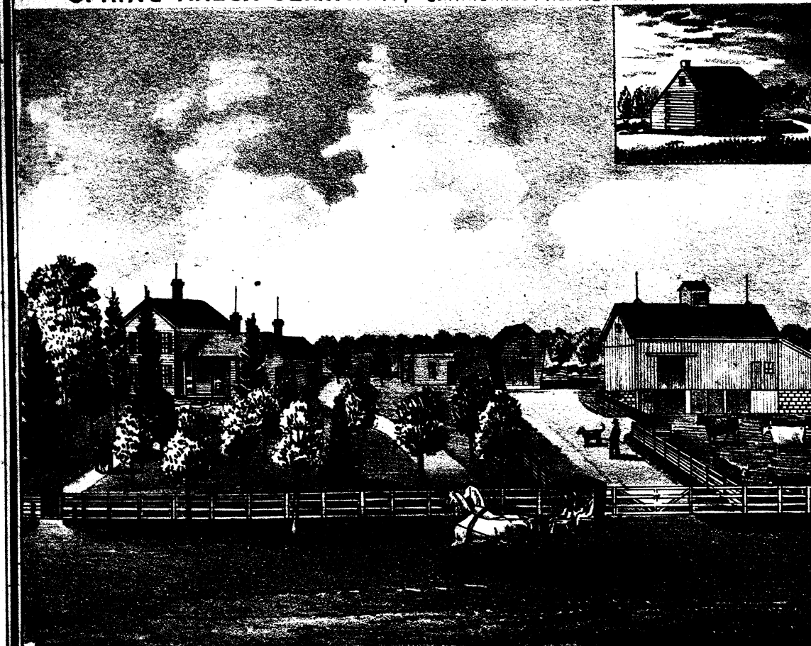
RES. OF S. H. LUDLOW, ESQ. SEC. 27 SPRINGPORT TP. MICH.
