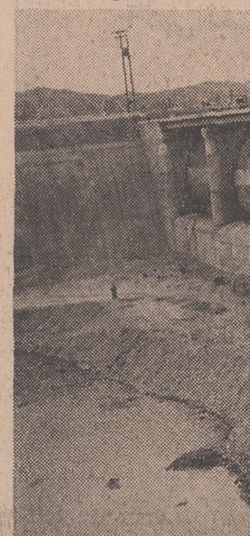
نمایی از سد تنظیم کننده در دست ساختمان از پشت سد واقع در ۴ کیلومتر و نیمه شمال پل قدیمی دزفول که ارتفاع آن ۲۰ متر و طول آن ۱۳۶ متر است. ظرفیت دریاچه ۱۶۰۰۰۰ متر مکعب و دارای ۶ سرریز و یک دریاچه آبیاری می باشد.
