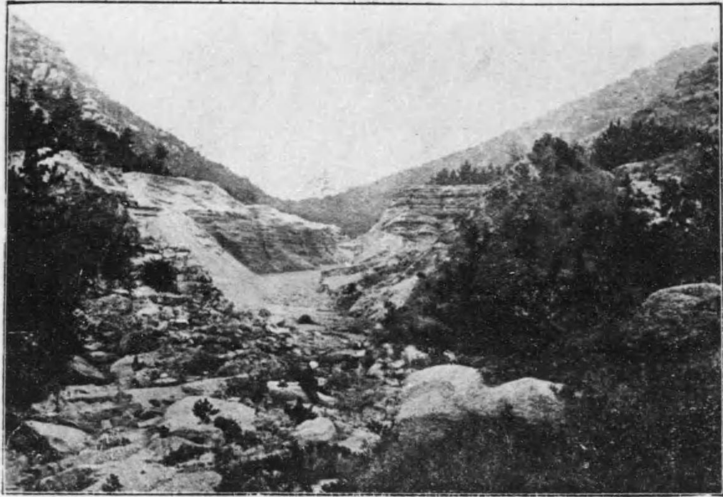
兒島郡宇野村内地砂防施工前ノ景光
