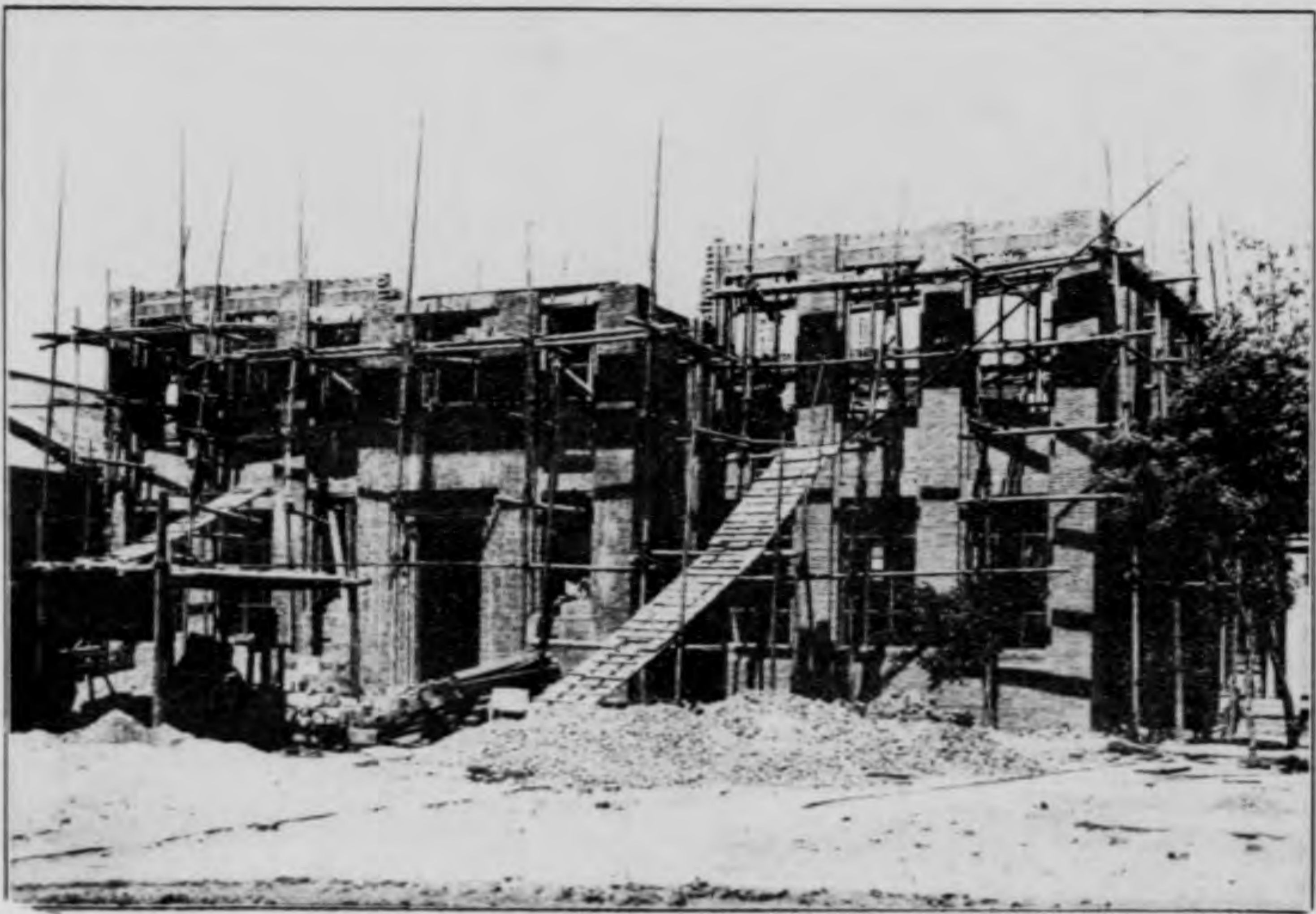
建築中之市政水利工程實驗館
