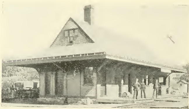
Stanfordville Station.—P., R. & N. E. R. R.
