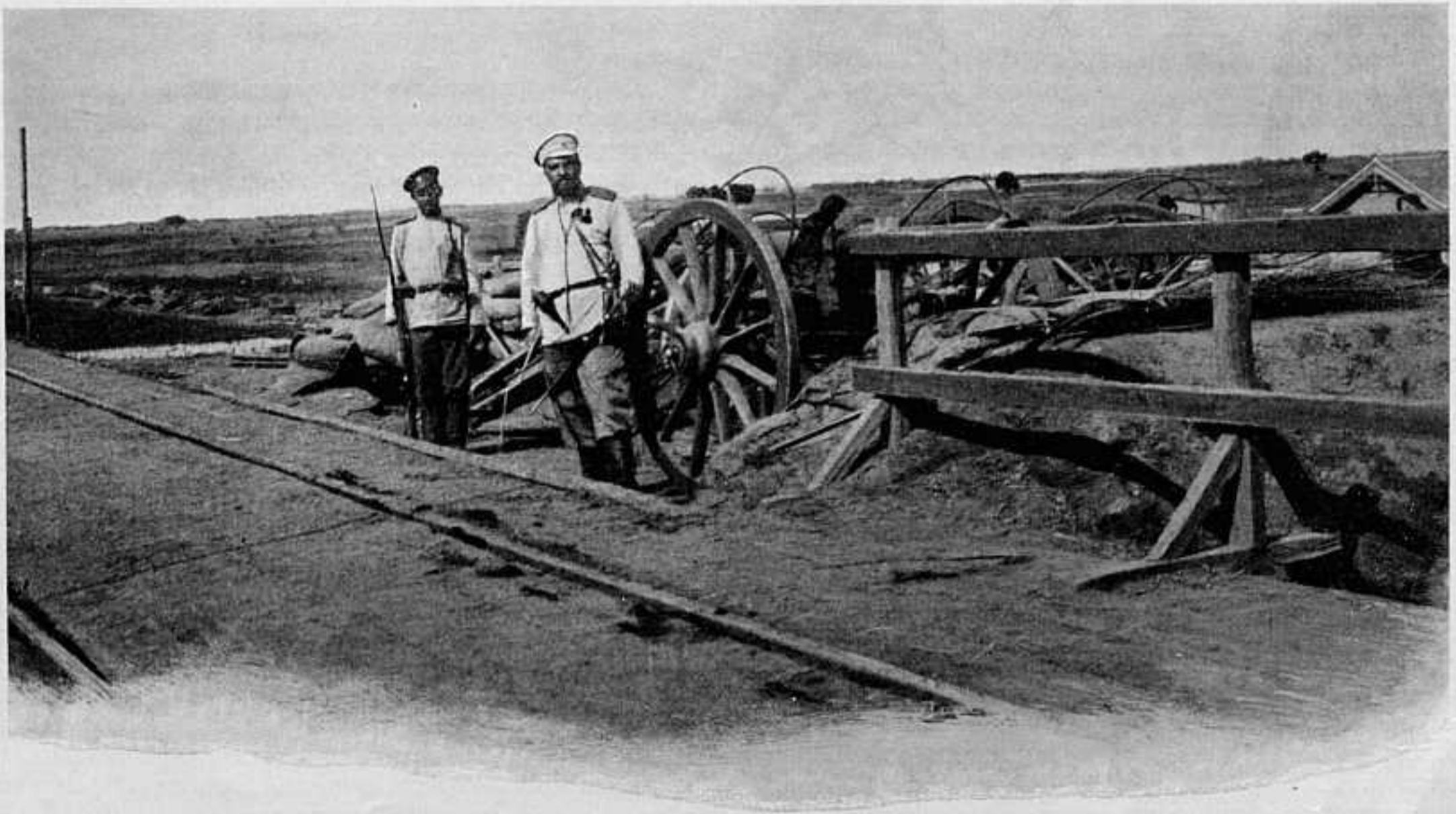
МУКДЕНЪ. УКРѢПЛЕНІЕ ЖЕЛѢЗНОДОРОЖНАГО МОСТА.
