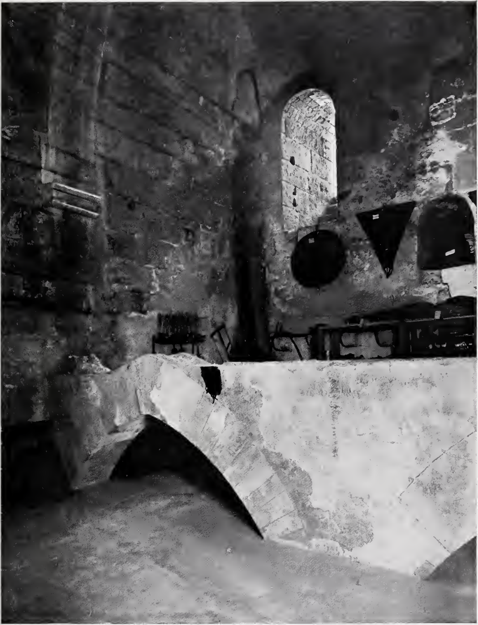
CASTELLO — INTERNO DEL MAGAZZINO DEL SEMAFORO.
