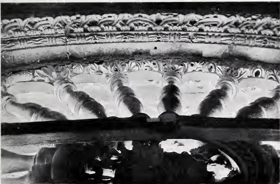
CATTEDRALE — PARTICOLARE DEL ROSONE, DALL'INTERNO.
