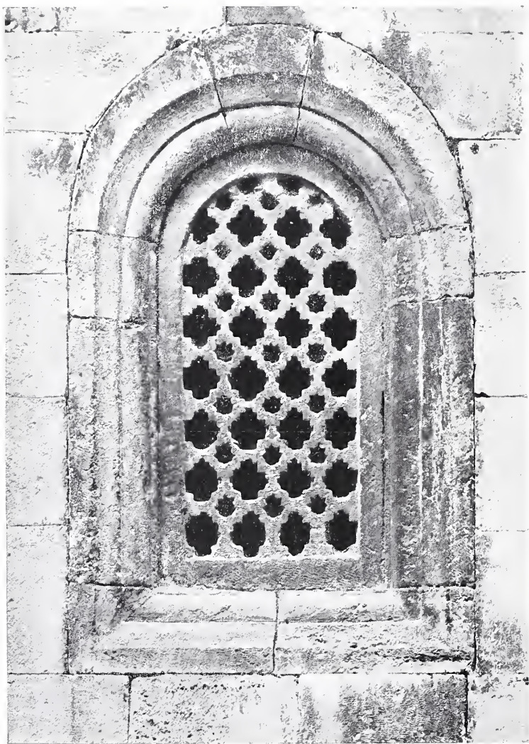
CHIESA DI S. GREGORIO — FINESTRA A TRAFORO.
