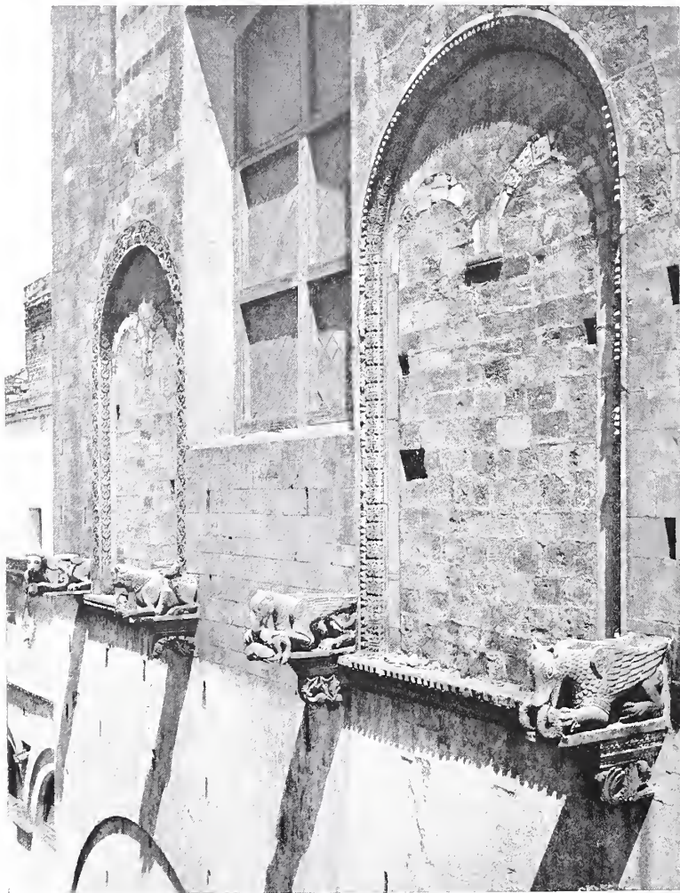
CATTEDRALE — FINESTRE MURATE NELLA TESTATA SUD.
