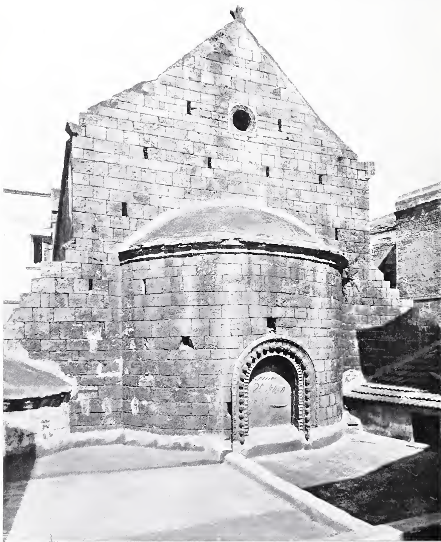
CHIESA DI S. GREGORIO — ABSIDE ESTERNA.
