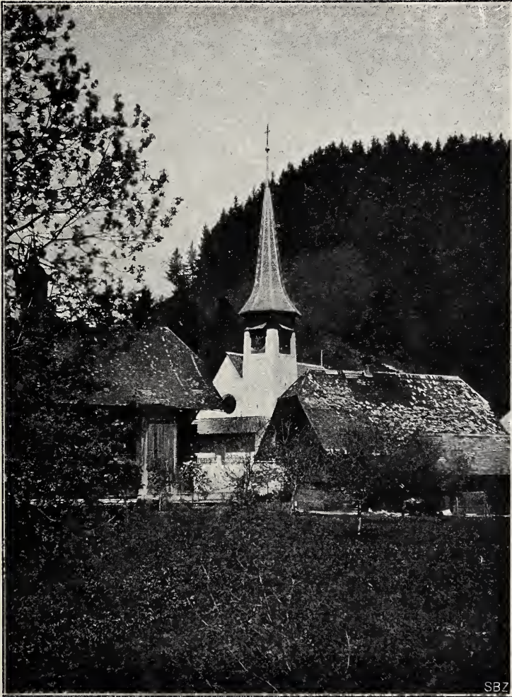
Ansicht von Südosten
