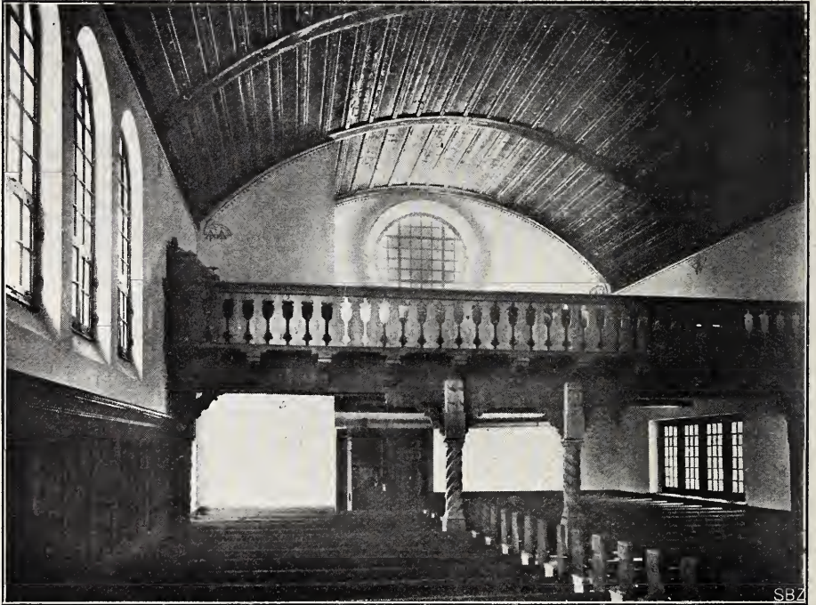
Innenansicht gegen die Portelaube
