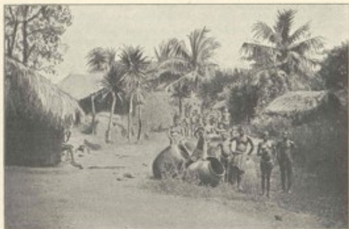
Das Dorf Kevega mit des grossen Wasserbehältern.
