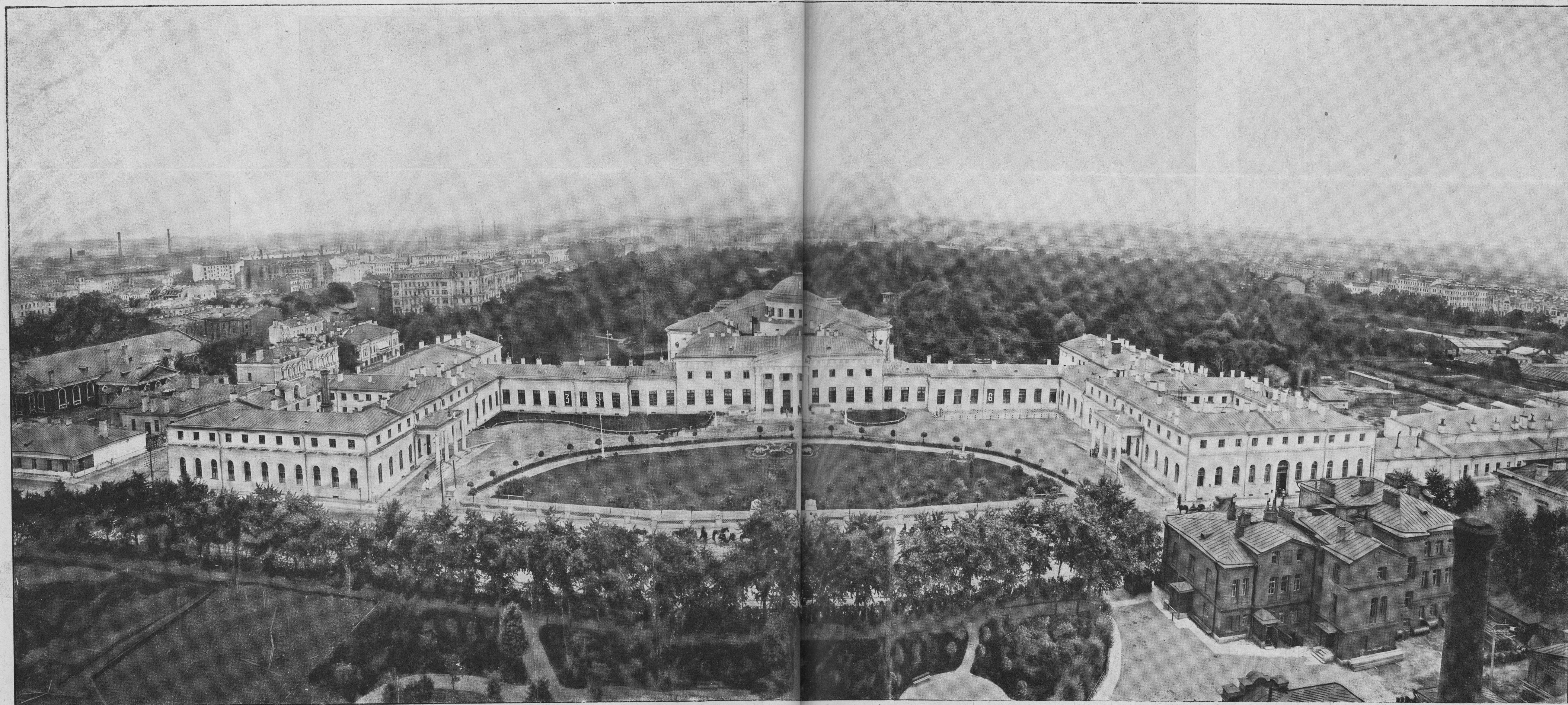
1) Помѣщеніе для канцеляріи Госуд. Думы, 2) отдѣленіе для министровъ, 3) коридоръ, соединяющій отдѣленіе министровъ съ заломъ Думы (тутъ жеется комната председателя Думы), 4) главный подъѣздъ въ Думу для гг. депутатовъ, 5) куполь надъ заломъ засѣданій Думы, 6) коридоръ и рядъ комнатъ, въ которыхъ помѣщаются: буфетъ, библиографъ и телефонъ Думы, 7) помѣщеніе для охраны.
