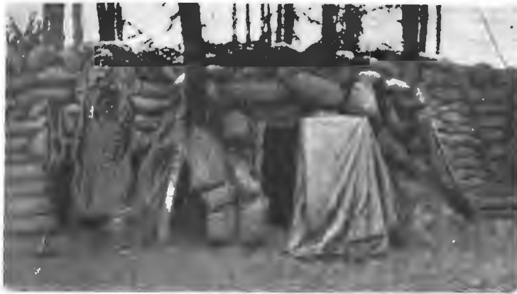
Норка, замѣняющая землянку, въ валу окопа изъ мѣшковъ.
