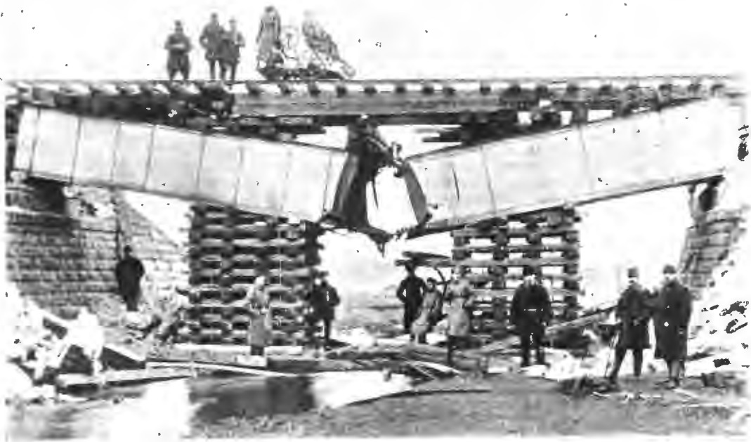
Разрушенія желѣзнодорожнаго пути близъ Вильны.
