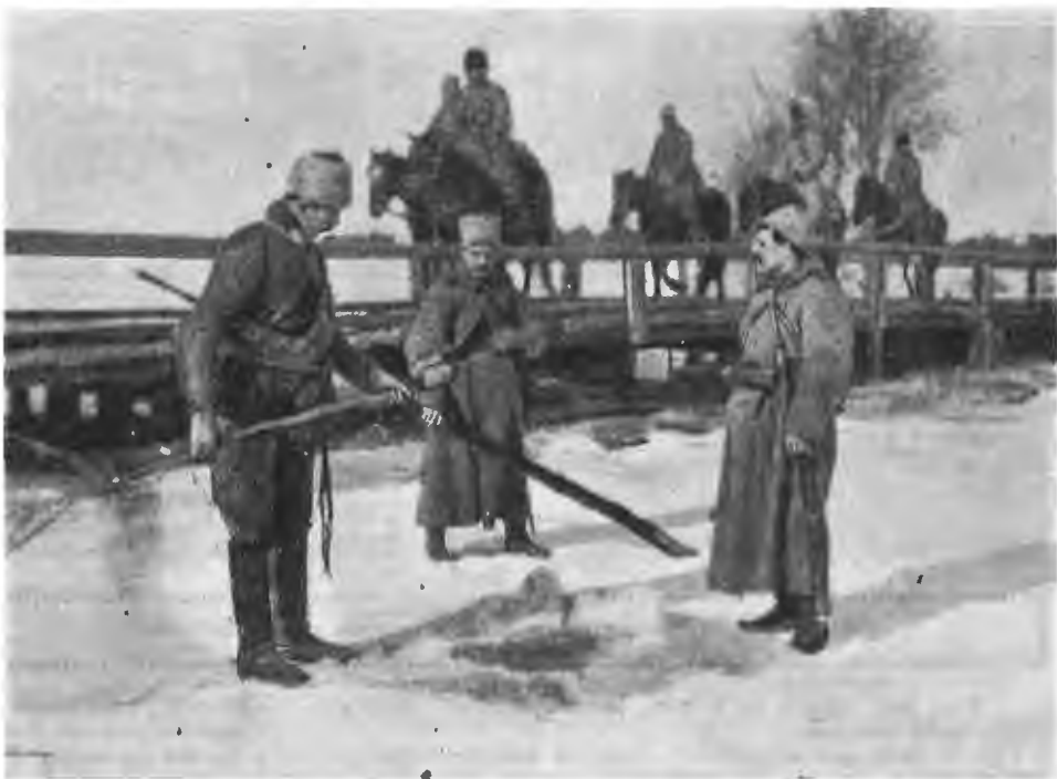
Взрывание льда для разрушения переправы. Два-три фунта пироксилина, опущенные в прорубь и взорванные там, взламывают лед на огромном пространстве вокруг проруби — больше 100 сажень в окружности.
