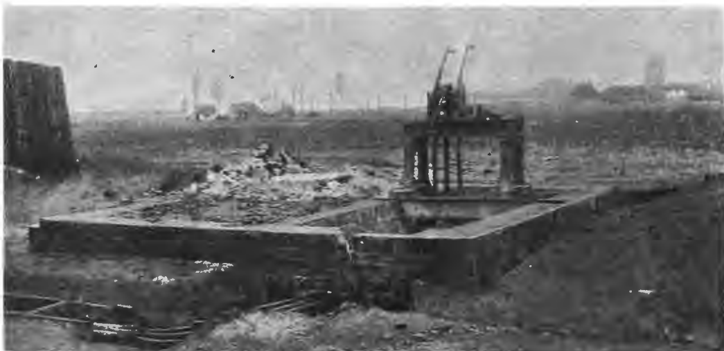
Все, что осталось отъ станціонной постройки на станціи С.
