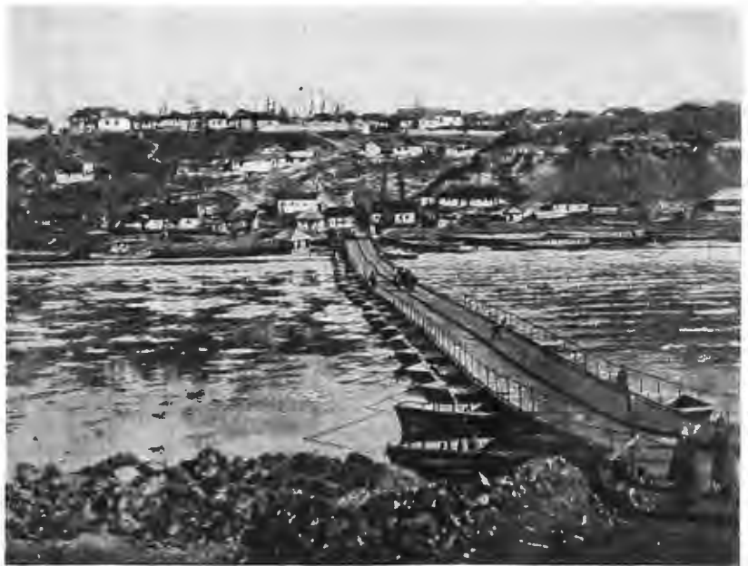
Наводка понтоннаго моста на рѣкѣ Д.
