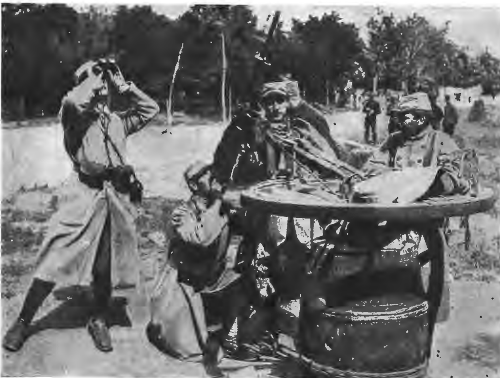
На западном фронте. Прimitивное приспособление пулемета для стрельбы по аэропланам. Колесо на бочкѣ служитъ поворотнымъ кругомъ.
