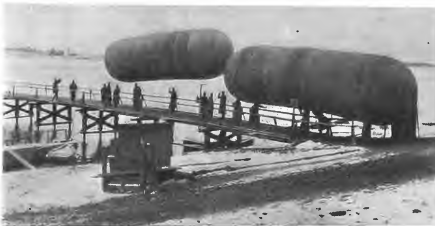
На нашемъ западномъ фронтѣ. Подготовка аэростата къ полету. Готовыя оболочки съ газомъ по дорогѣ къ аэростату для его наполненія.
