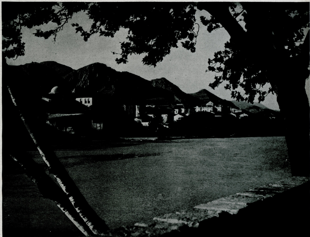
Vue partielle d'Antakya (Antioche)
