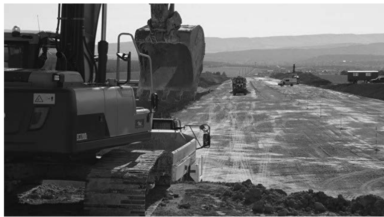
Будівництво траси «Таврида».
