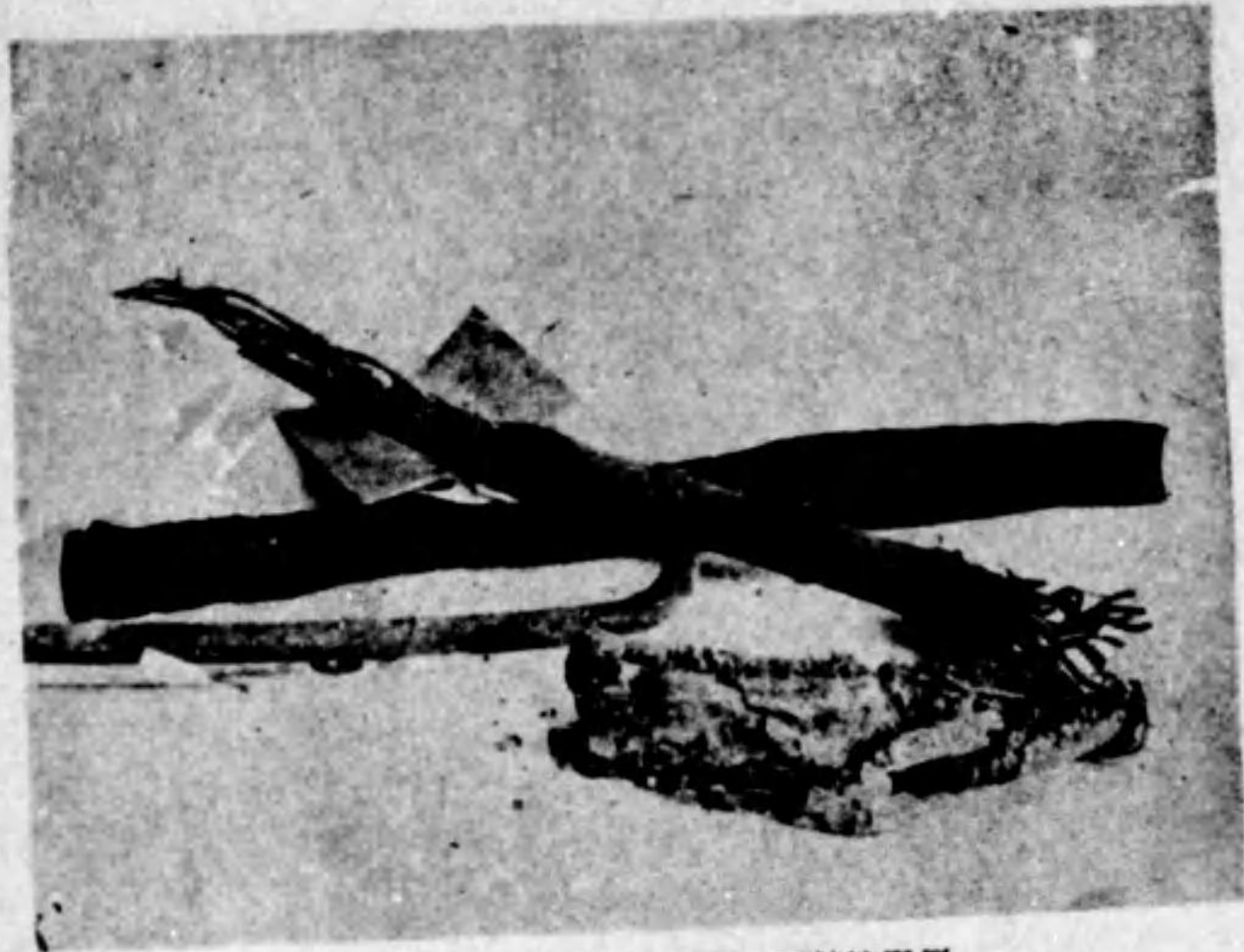
第 3 圖 電鐵補助路線の電蝕被害例
