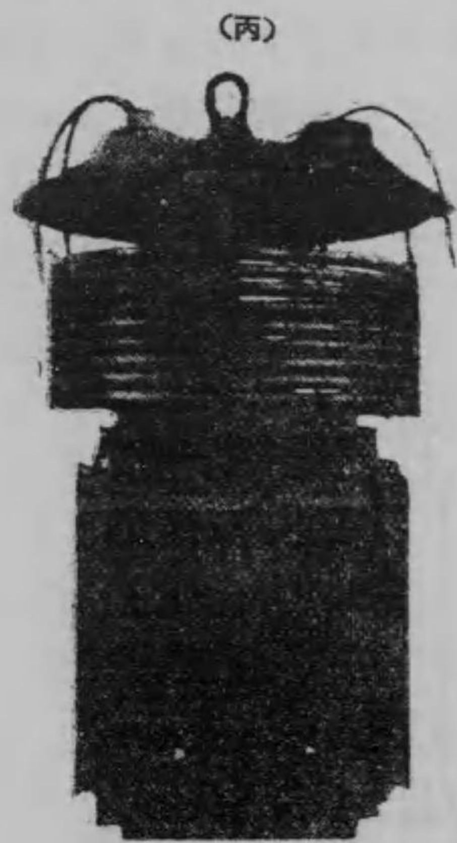
(丙) 500「キロヴォルトアムペア」 3,300「ヴォルト」 水冷油入變壓器 (芝浦製作所製)
