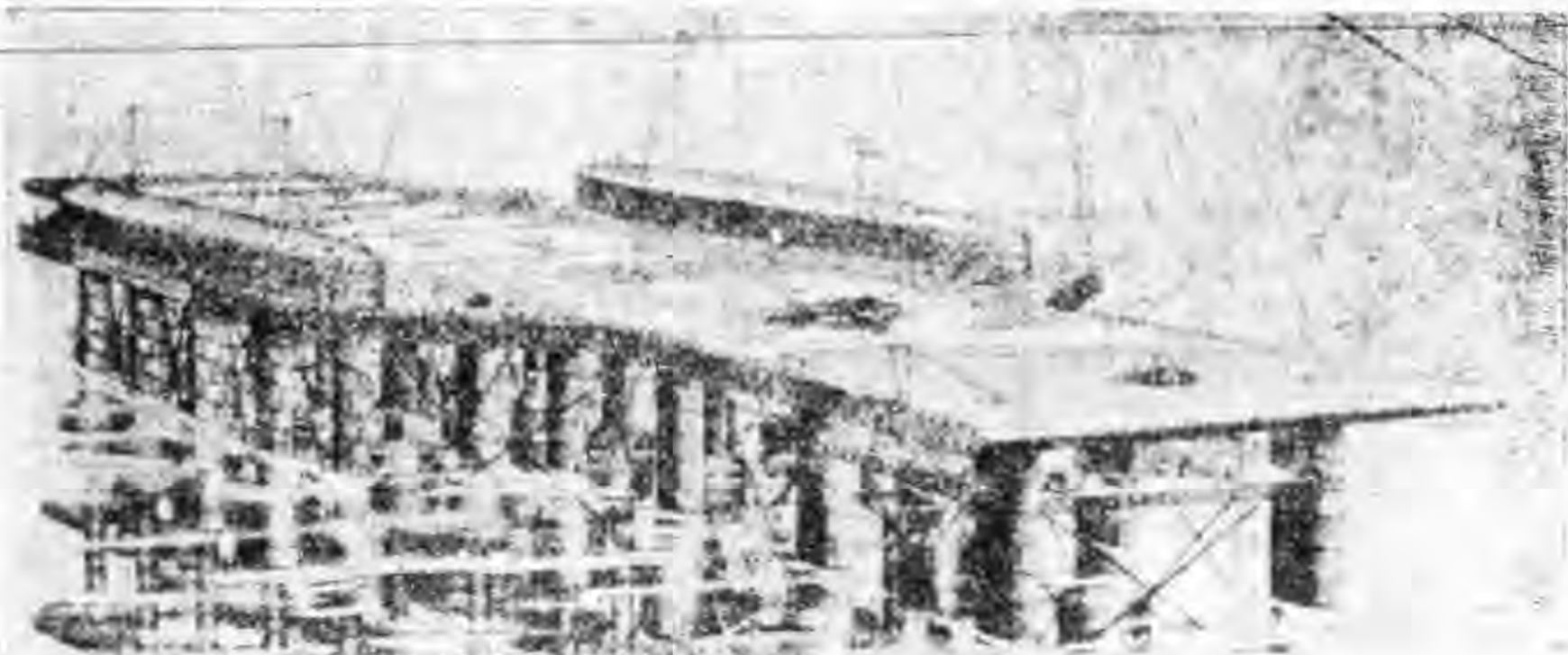
圖上為一完成之海面航空場及其上下甲板之設備
