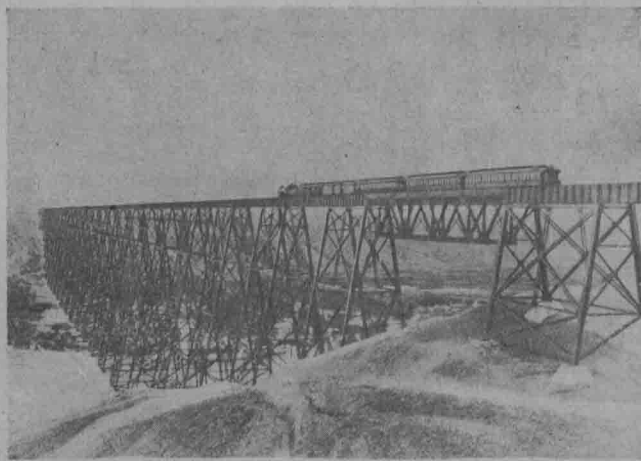
坎拿大太平洋洋鐵路的長橋
