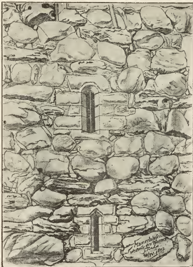
Fig. 144. Schloss Mammertshofen. Mauerwerk an der Westseite des Thurmes.
