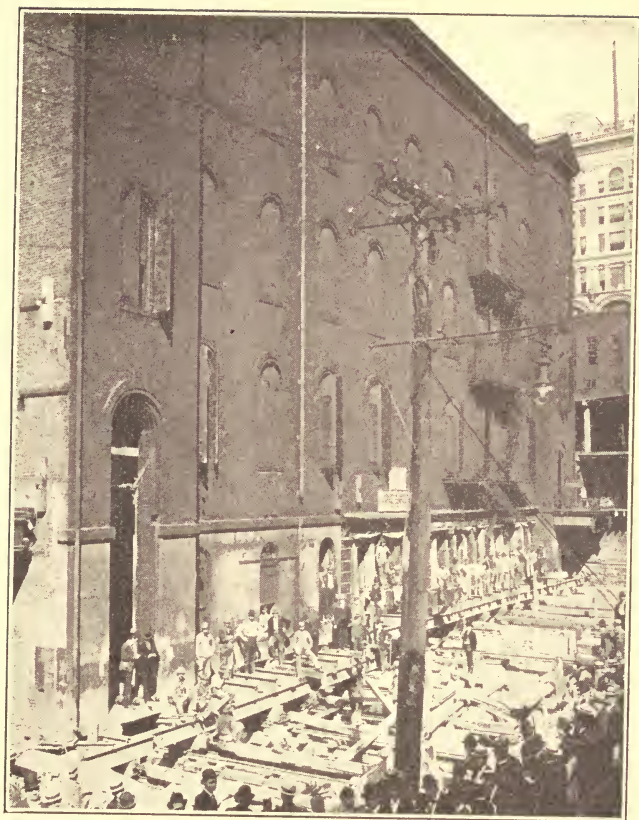
Comment le « Grand Opera House » de Pittsburg a changé d'emplacement. — Vue de derrière.
