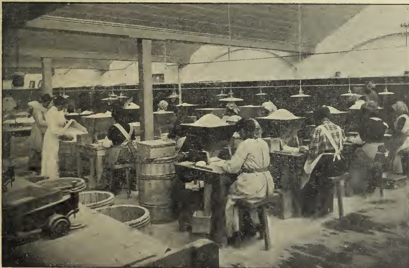
Fig. 4. Handsortierung und Ausklauben von Verunreinigungen im Kryolith.
