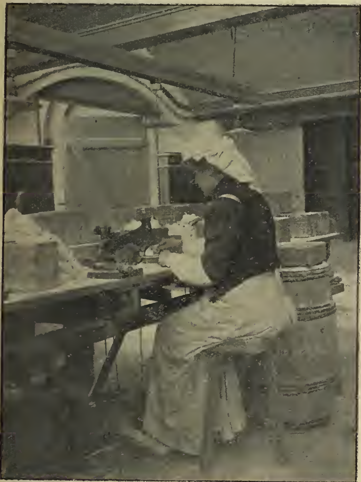
Fig. 3. Abklopfen der Begleitminerale oder Einsprengungen im Kryolith mittels Hämmerchen und Handsortierung.
