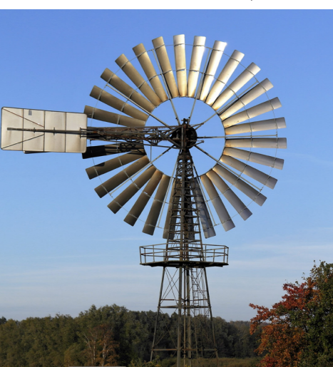
Windrad, Windschöpfwerk Lobbe, Middelhagen (Mecklenburg-Vorpommern), Bild: Bybösch, Christian Gebhardt, CC-BY-SA 4.0*
