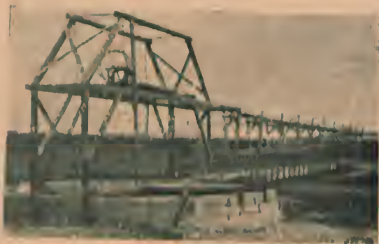
Fig. 6 — Um grande silo subterrâneo com o seu respectivo apparelho para a elevação e transporte da ensilagem por cima dos comedouros do gado.
