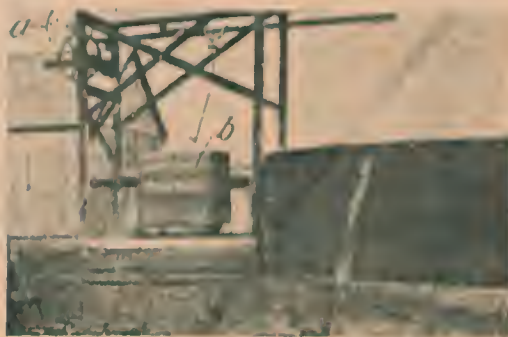
Fig. 3—Um silo subterrâneo bem cercado, com um guindaste à força de braço combinado com um condactor para a ensilagem
