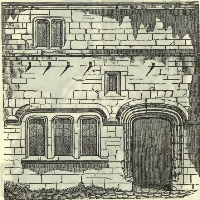
EXTÉRIEUR DES CUISINES.
