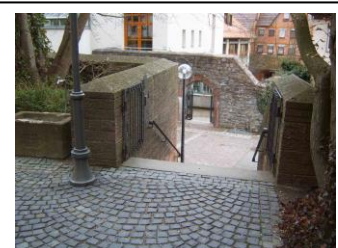
Simmozheim-Kirchhof im Süden mit Kirchhofmauer und ehemaligem Kammertor (Außenbogen erhalten)-270108
