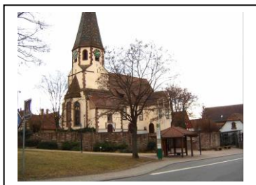
Althengstett-Ansicht von Nordosten mit Kirche über Kirchhofmauer und ehemaligem Grabenbereich-270108
