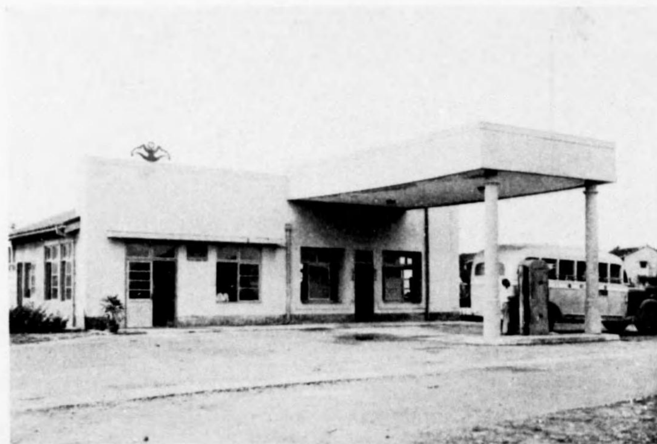
臺灣苗栗壓縮瓦斯充填所 昭和十五年十一月竣工 使用壓縮機(獨逸製) 能力 120 立方尺/時間 動力 ガスエンジン
