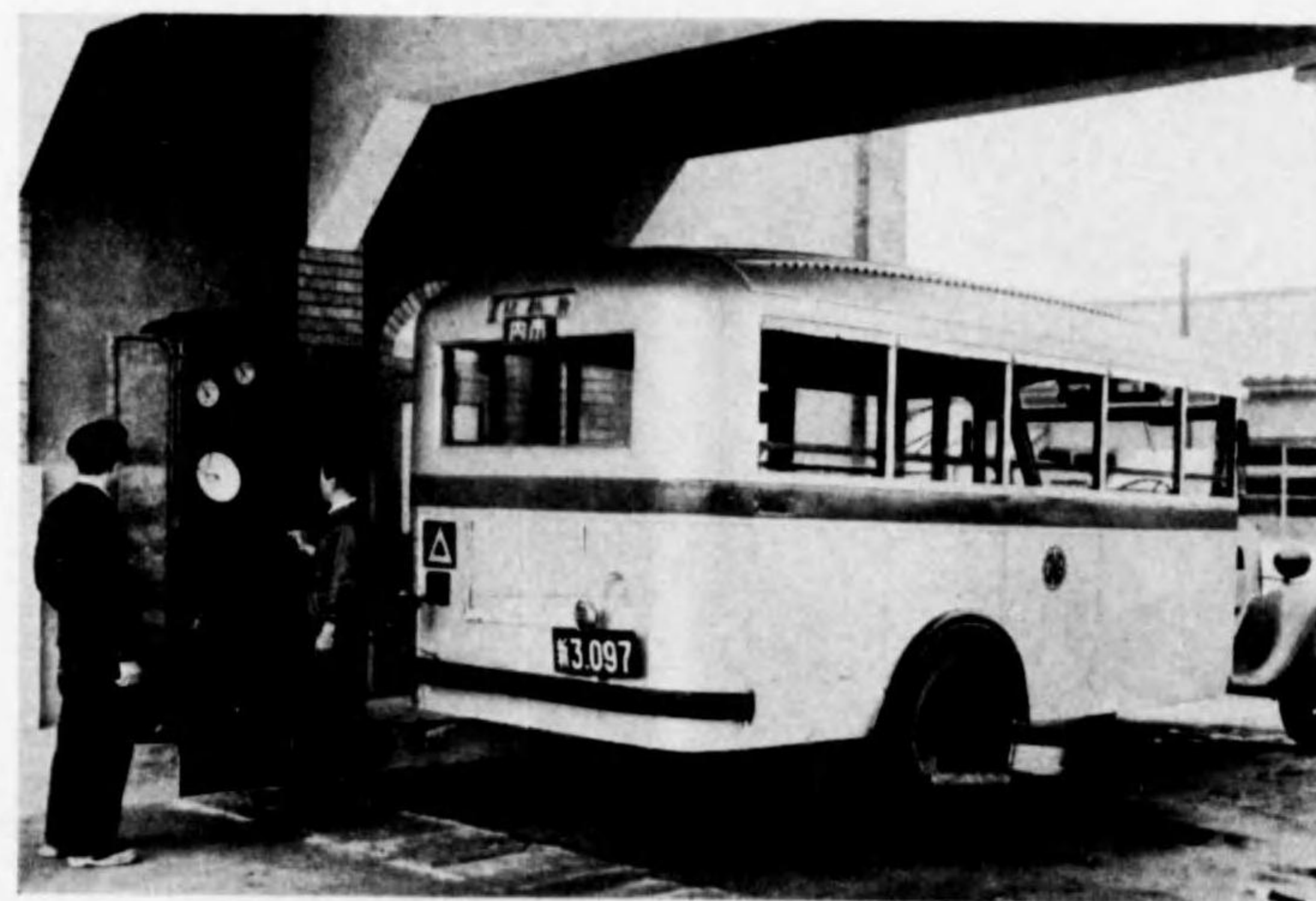
新潟壓縮瓦斯充填所 フイリングスタンド
