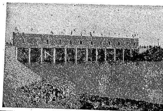
不久前完工的山东打渔张引黄灌区的渠首引黄闸全部，它长达89点6公尺，高9公尺，设有12个闸门。在常年平均枯水的情况下，引水量为120秒公方。
