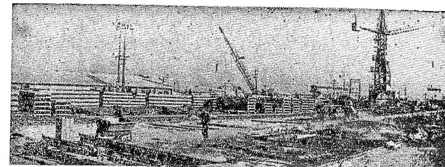
节约钢材的先进技术——预应力钢筋混凝土，已在湘北太原工务局河西预制厂试制成功。这种混凝土可代替金属构件的厂房屋架，比一般金属屋架节约钢材40—60%。图为试制厂和预制应力钢筋混凝土制品。
