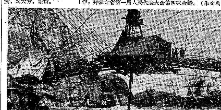
劉家峽水電站壩址正在進行河心鑽探。劉家峽水電站的壩址選定以後，工人們正在壩址區進行大規模的河心鑽探，爭取在今年年底以前確定壩址軸線。這是安設在壩址區黃河水面上的鑽機群。
