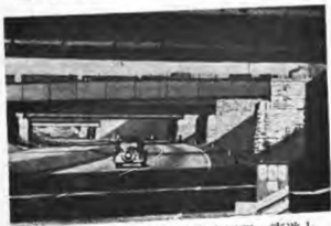
汽車道通過工業區之偉大工程，車道上面接連的都是火車軌道和其他道路，有六百公尺之長。
