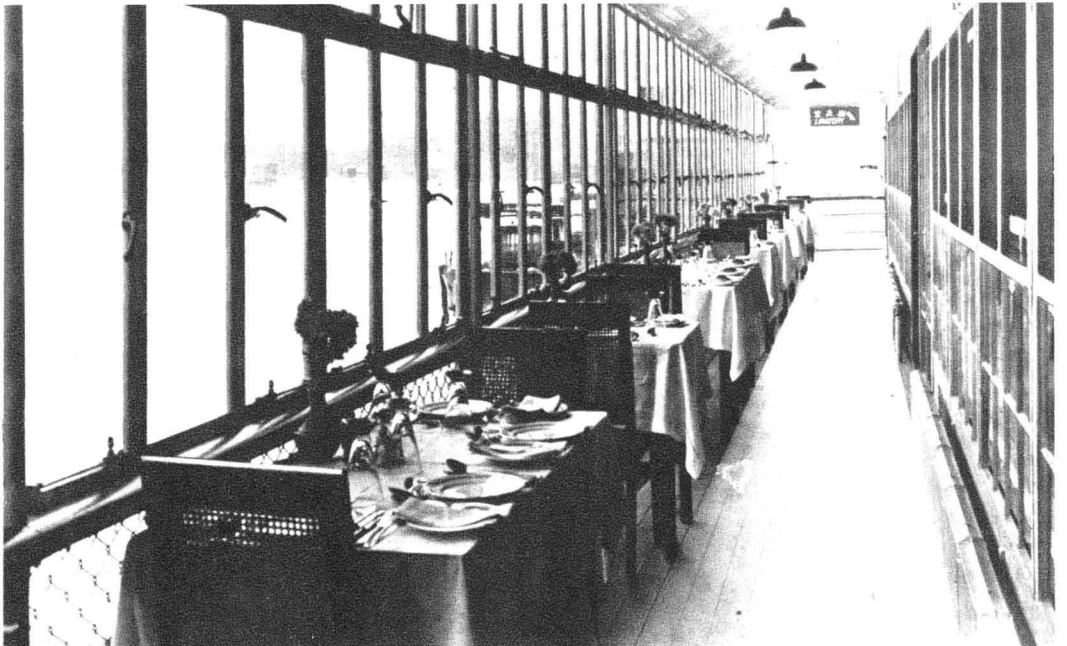
加裝鋼窗暖氣後之陽台
