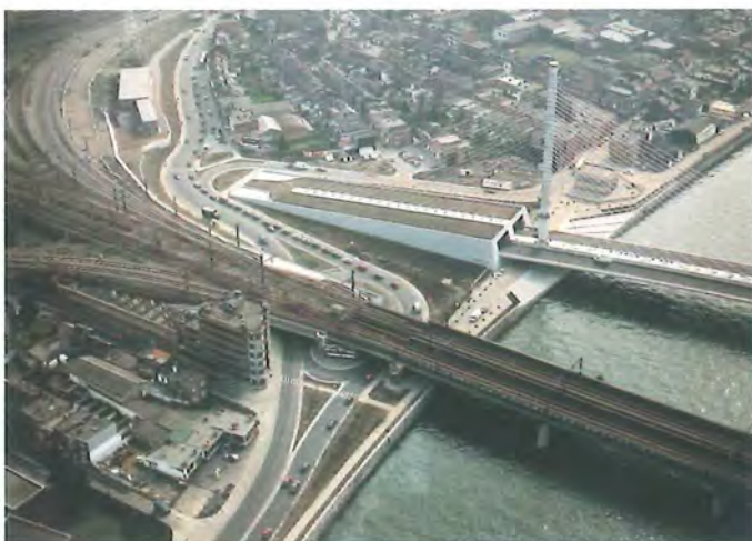
Figure 73 : le pont sur la Meuse – La culée-contrepoids et l'aménagement des abords de Kinkempois, en mars 2000 • © D. 434 (n° 00/949)
