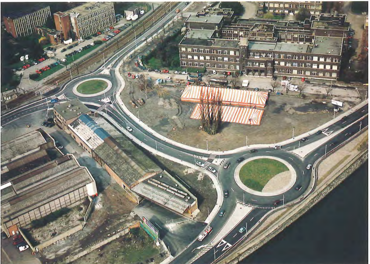
Figure 66 : les nouveaux ronds-points de l'échangeur, adaptés au volume du trafic et à la configuration des lieux, doivent garantir une sécurité maximale aux usagers (vue de mars 2000). • © D. 434 (n° 00/951)
