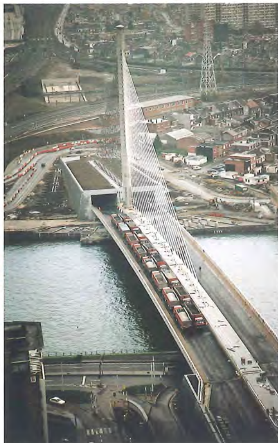
Figure 79 : essai de charge du pont le 27 novembre 1999 © D. 434 (n° 99/3541)
