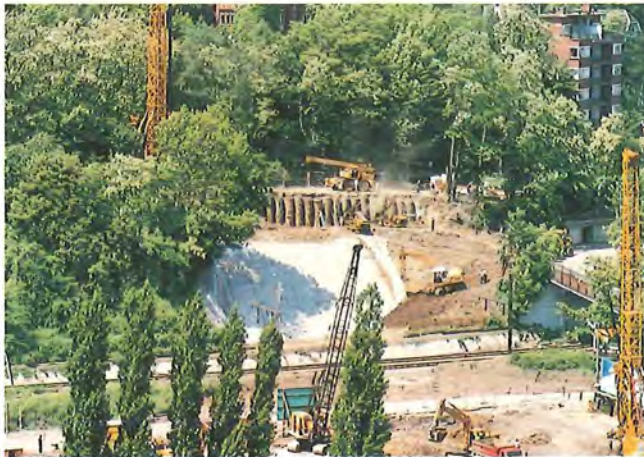
Figure 37 : vue, en 1986, du chantier de construction de la tête « Tilleuls », qui doit passer sous la rue Solvay et sous deux voies de chemin de fer importantes (ligne Liège-Namur) • © A. Maréchal
