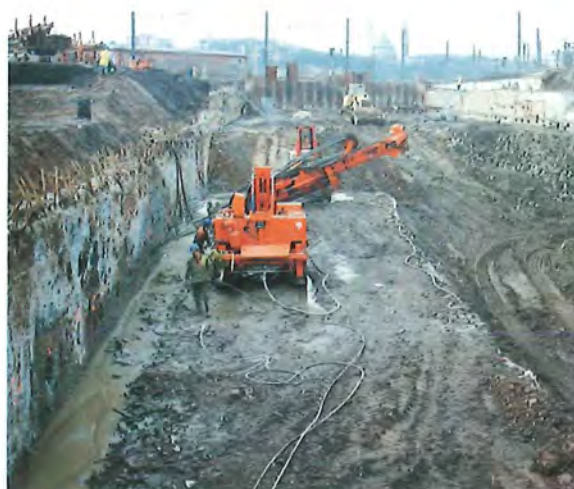
Figures 100 et 101 : la réalisation des parois moulées du tunnel de Kinkempois – Le bétonnage, la récupération de la bentonite et les ancrages soutenant les parois moulées • © V. Remy et D. 434 (n° 97/00682)
