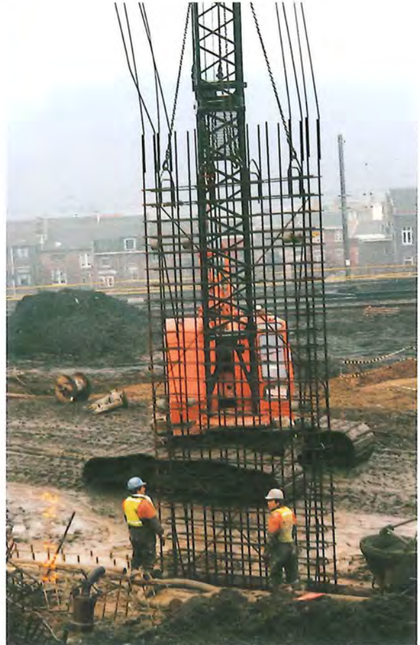
Figures 98 et 99 : la réalisation des parois moulées du tunnel de Kinkempois – À gauche, le grappin, utilisé pour l'excavation entre les murets-guides ; à droite, la mise en place, après excavation et avant bétonnage, des cages d'armature (décembre 1997) © Daylight et V. Remy
