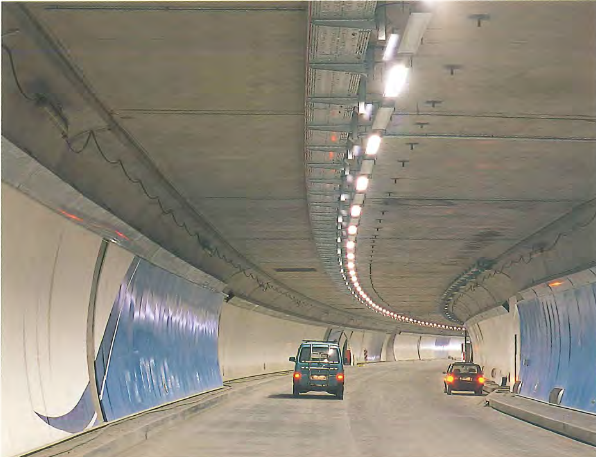
Figure 36 : l'un des deux tunnels de Cointe, avec ses parachèvements (avril 2000) • © Daylight
