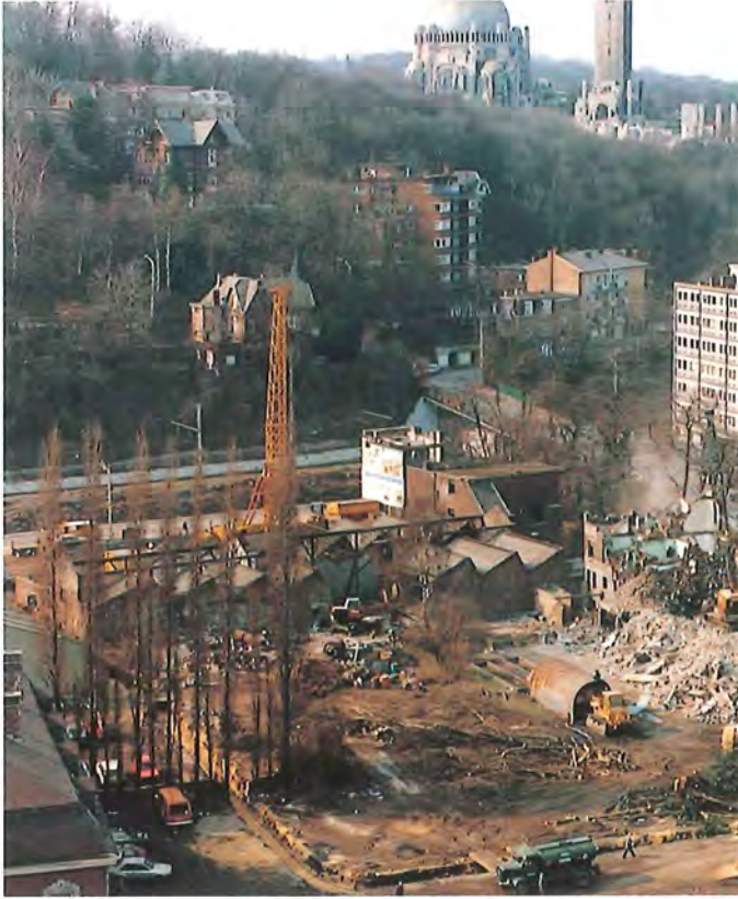
fig. 59 : le chantier en mars 1986 • © A. Maréchal
