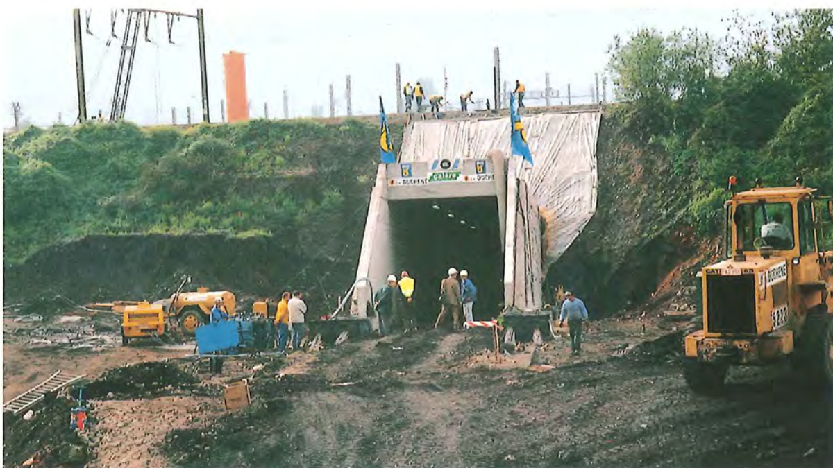
Figures 92 et 93 : le pont ferroviaire, mis en place par ripage latéral, et le tunnel d'accès (novembre et octobre 1996) © Daylight et V. Remy
