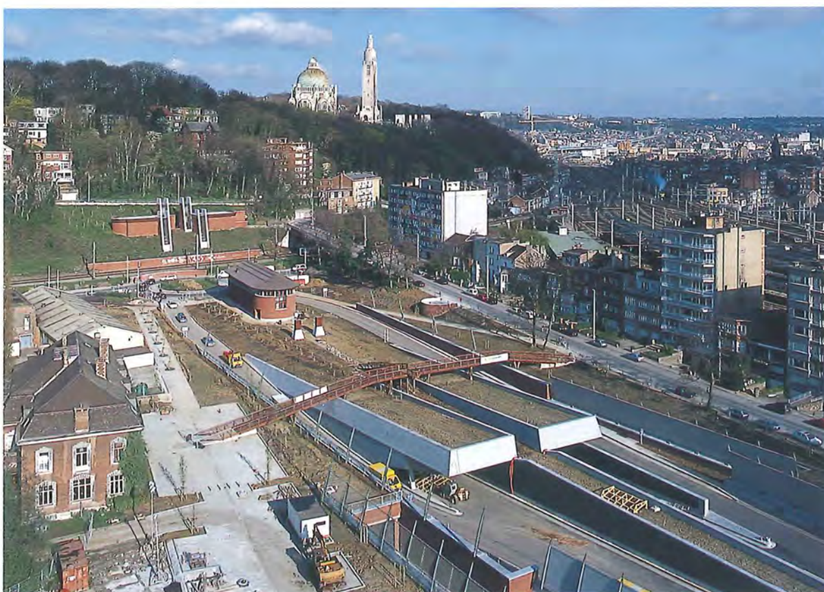
fig. 63 : le chantier en avril 2000 • © Daylight
