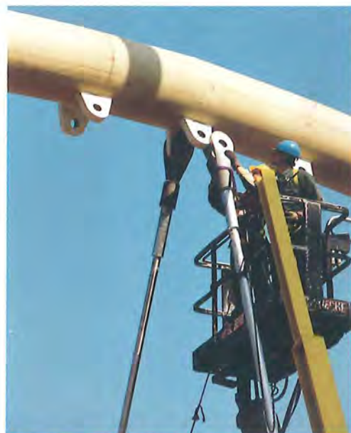
Figure 30 : pose des premières suspentes du Bowstring, le 23 mars 2000 • © D. 434 (n° 00/1173)
