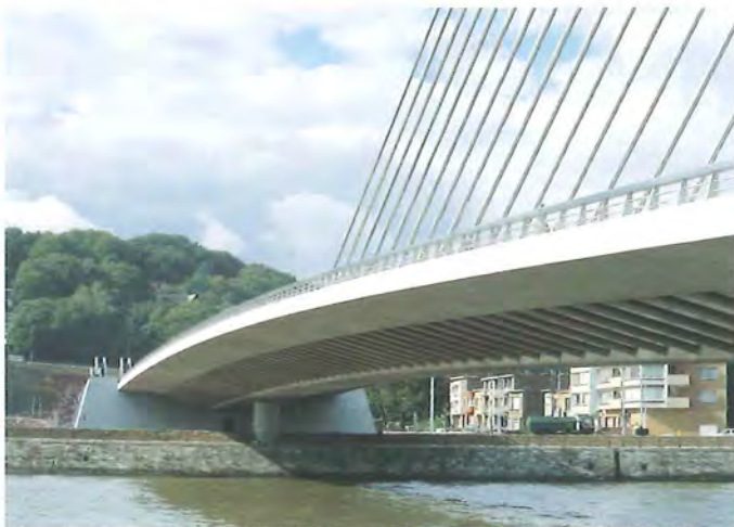
Figure 72 : les bracons sous le tablier du pont (vue d'octobre 1999) © Daylight
