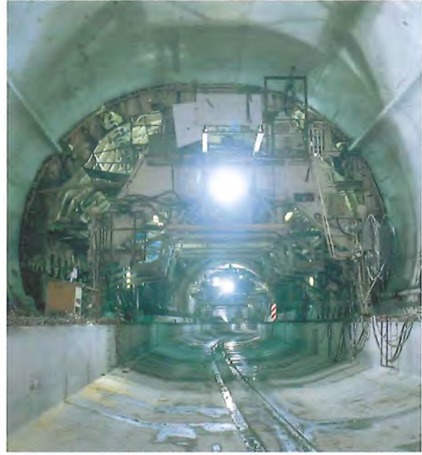
Figures 51 et 52 : ces deux figures illustrent très bien l'adaptation latérale nécessaire du portique de bétonnage dans une section élargie, illustrée sur la photo de droite (vues d'août 1998). • © A. Maréchal et Daylight
