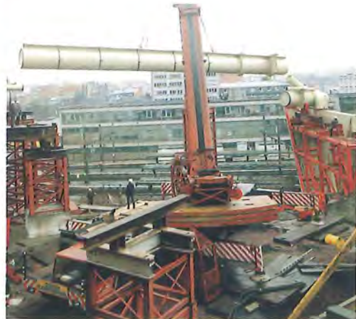
Figure 28 : positionnement du troisième tiers du tube-tirant, entre les deux premiers et le pied d'arc situé sur la palée AA, à la jonction entre le Bowstring et le viaduc ; complication importante, ce pied d'arc se situe exactement au-dessus de la voie ferrée du quai n° 14 de la gare des Guillemins (décembre 1999). © D. 434 (n° 99/3737)
