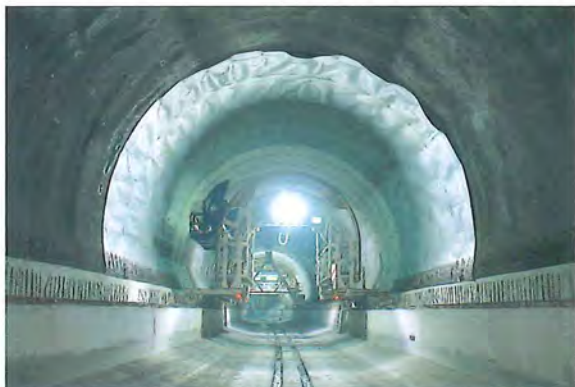
Figures 48 et 49 : pose du drain et de la membrane (vues de septembre 1997 et d'août 1998) • © Daylight
