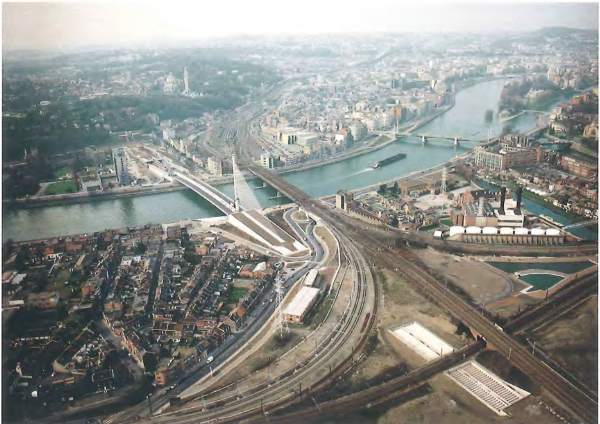
Figure 114 : les équipements de la nouvelle liaison autoroutière ont été conçus pour la sécurité et le confort des usagers. On remarque par exemple, à l'avant-plan, le toit ajouré des tunnels de Kinkempois, conçu pour assurer la ventilation. © D. 434 (n° 00/989)
