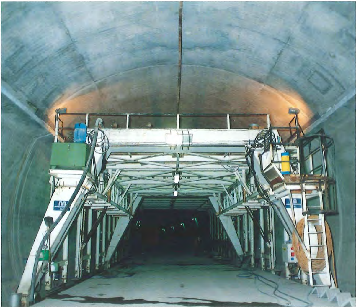
Figure 54 : portique de faux plafond (1998) • © A. Maréchal
