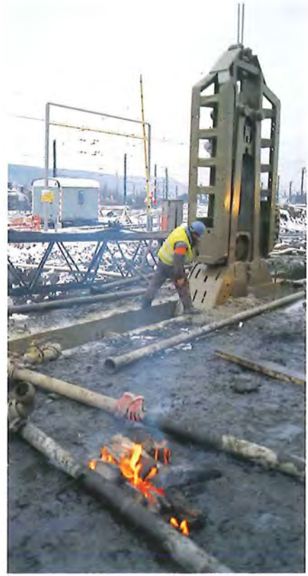
Figures 96 et 97 : la réalisation des parois moulées du tunnel de Kinkempois (phase 1) – Les murets-guides et les travaux d'excavation entre les murets (décembre 1997) • © V. Remy et Daylight
