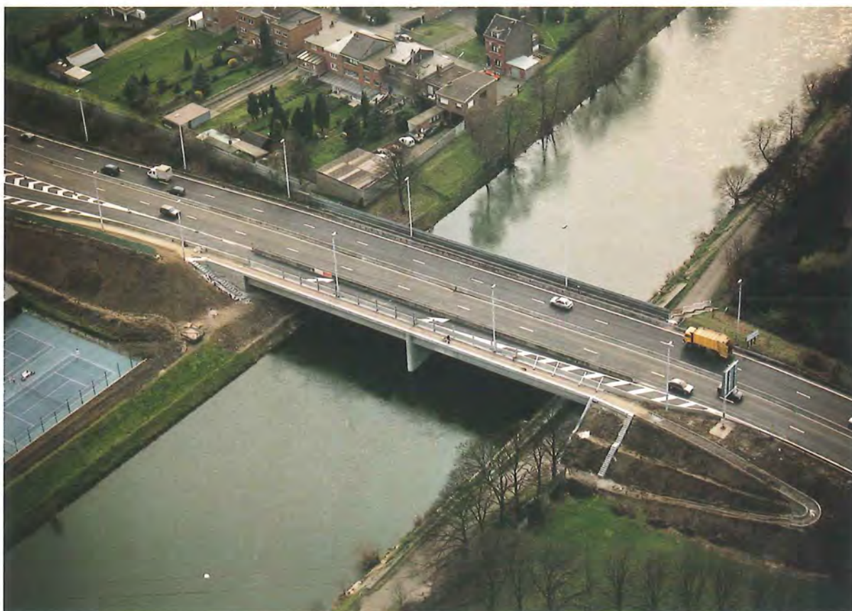
Figure 113 : le pont élargi avec, à l'avant-plan, les accès et les trottoirs aménagés pour les piétons (mars 2000) © D. 434 (n° 00/973)
