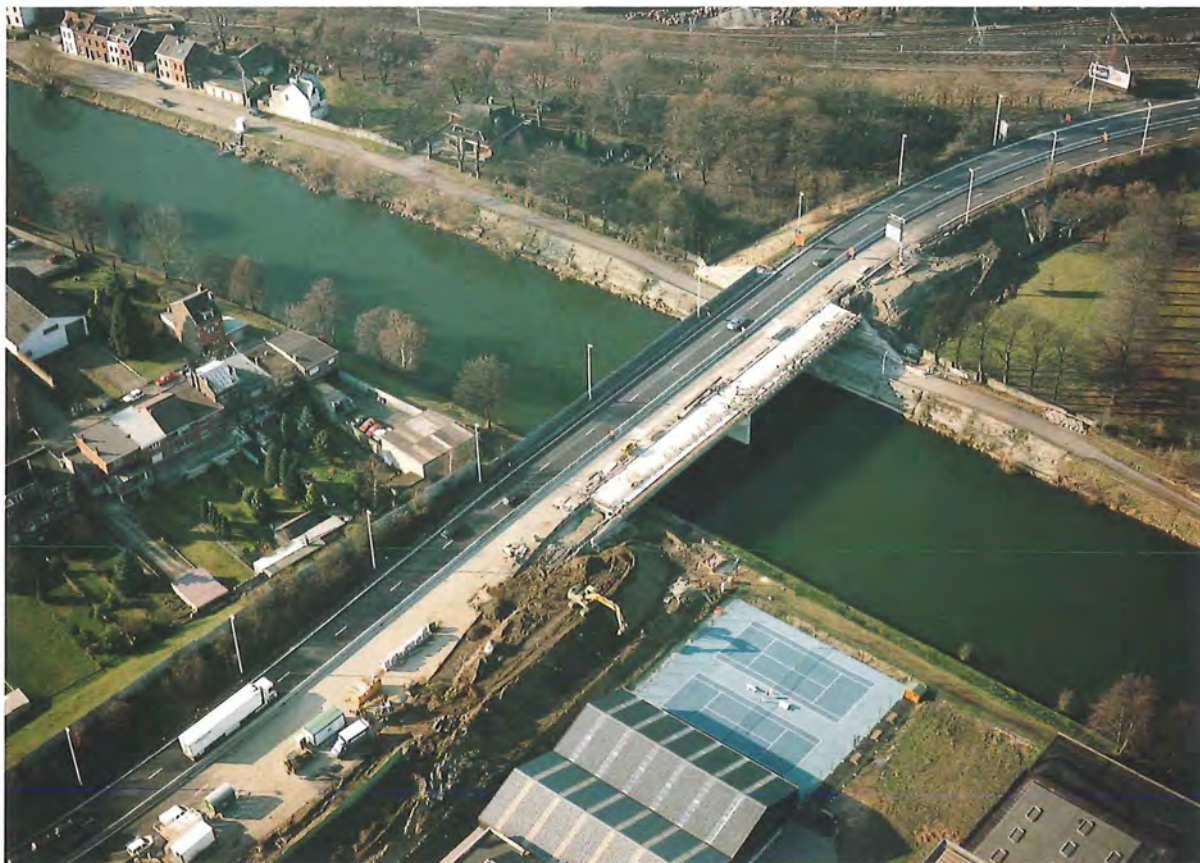
Figure 112 : le pont de Sauheid, en cours d'élargissement sur l'Ourthe à Chênée, en janvier 2000 – Les travaux doivent améliorer la sécurité des trafics routier et piéton à cet endroit. • © D. 434 (n° 00/153)
