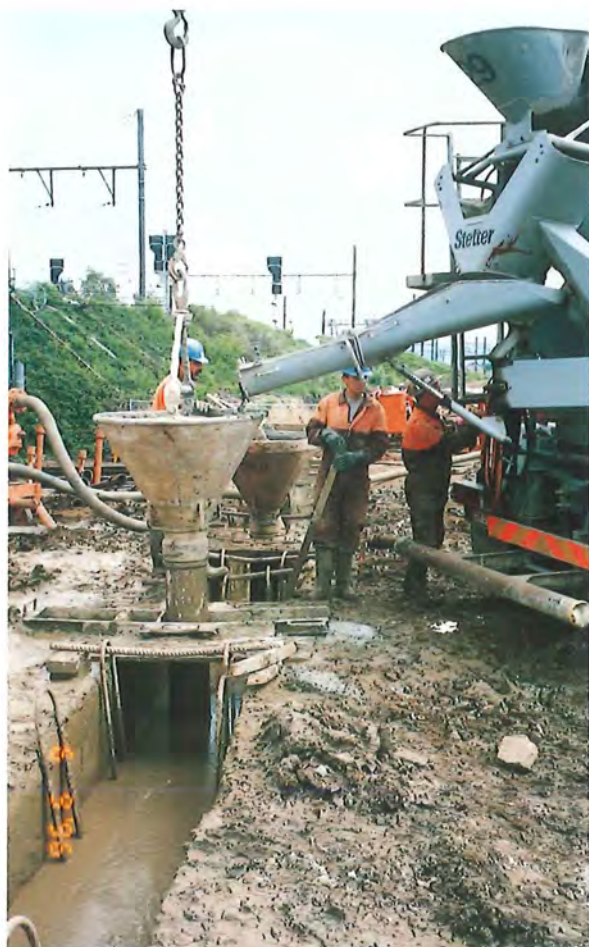
Figures 100 et 101 : la réalisation des parois moulées du tunnel de Kinkempois – Le bétonnage, la récupération de la bentonite et les ancrages soutenant les parois moulées • © V. Remy et D. 434 (n° 97/00682)
