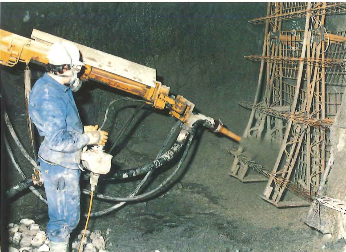
Figures 44 à 46 : mise en place d'un cintre réticulé, pose d'un treillis métallique et gunitage*, en 1988 – Le positionnement correct du cintre est indispensable au respect du tracé, tant en plan qu'en niveau. L'implantation est donc guidée par deux rayons laser matérialisant l'axe optique de deux théodolites*. • © MEF
