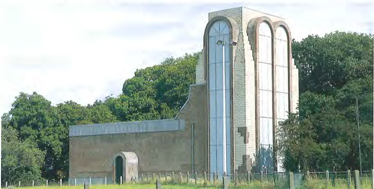
Figure 34 : la cheminée d'extraction de l'air vicié, située au Chéra, sur le plateau de Cointe (voir le point 6.2, consacré à la ventilation, pp. 85-87) • © Daylight
