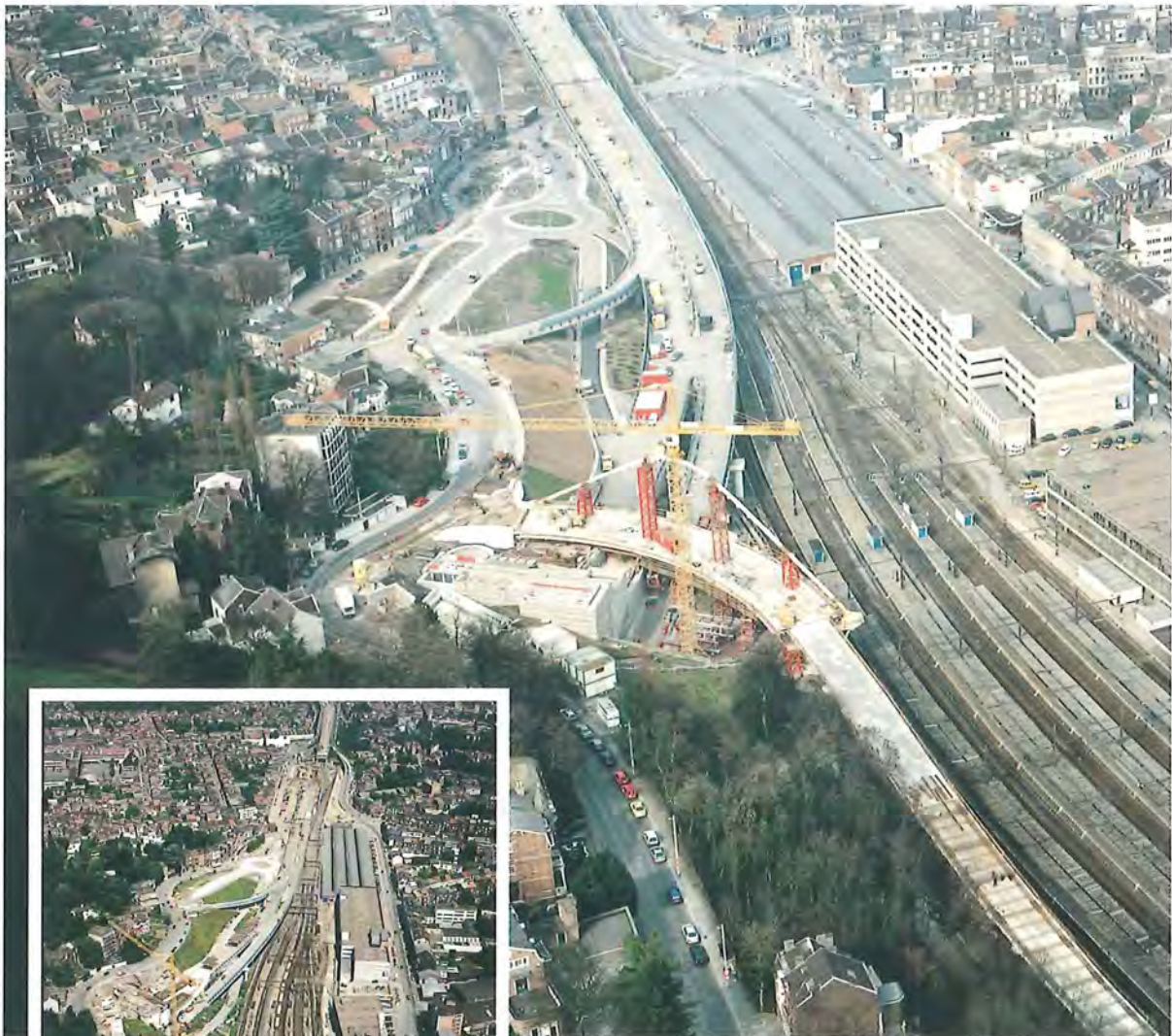
Figure 23 : le site en mars 2000 – À l'avant-plan, le futur pont de l'Observatoire, dont l'arc vient d'être monté en cinq tronçons, et le viaduc qui le prolonge – On le voit, entre la colline de Cointe et la gare, la configuration des lieux rendait délicate l'exécution des travaux.
