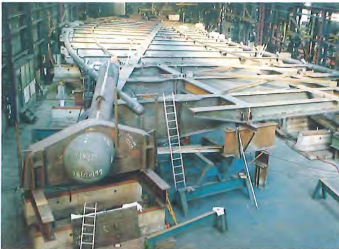
Figure 27 : montage à blanc du tablier du Bowstring en atelier (octobre 1999) • © D. 434 (n° 99/3046)
