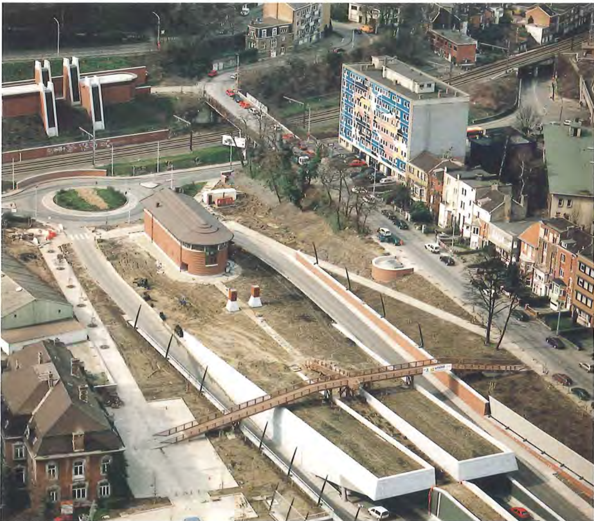
Figure 57 : la tête « Tilleuls » avec la sortie des tunnels ; l'échangeur ; la passerelle en bois, entre l'avenue des Tilleuls et le Val-Benoît ; le poste de commande, véritable centre nerveux de la liaison, au cœur même de l'échangeur ; et les prises d'air frais (mars 2000) • © D. 434 (n° 001/1010)
