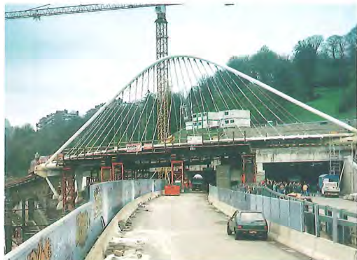
Figure 21 : vue du pont après la pose des suspentes (avril 2000) • © D. 434
