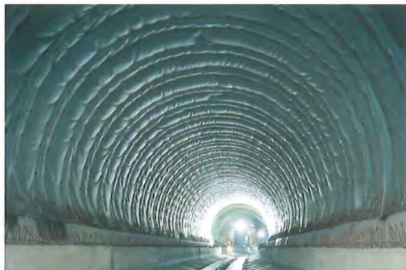
Figures 48 et 49 : pose du drain et de la membrane (vues de septembre 1997 et d'août 1998) • © Daylight
