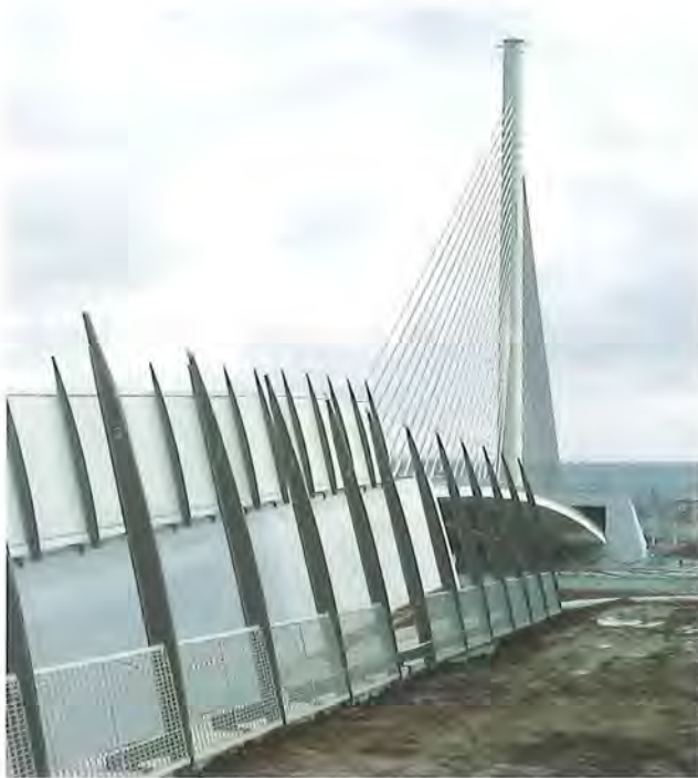
Figure 124 : exemple de protection acoustique dans l'échangeur des Tilleuls – À l'arrière-plan, le pont haubané sur la Meuse (février 2000) © Daylight
