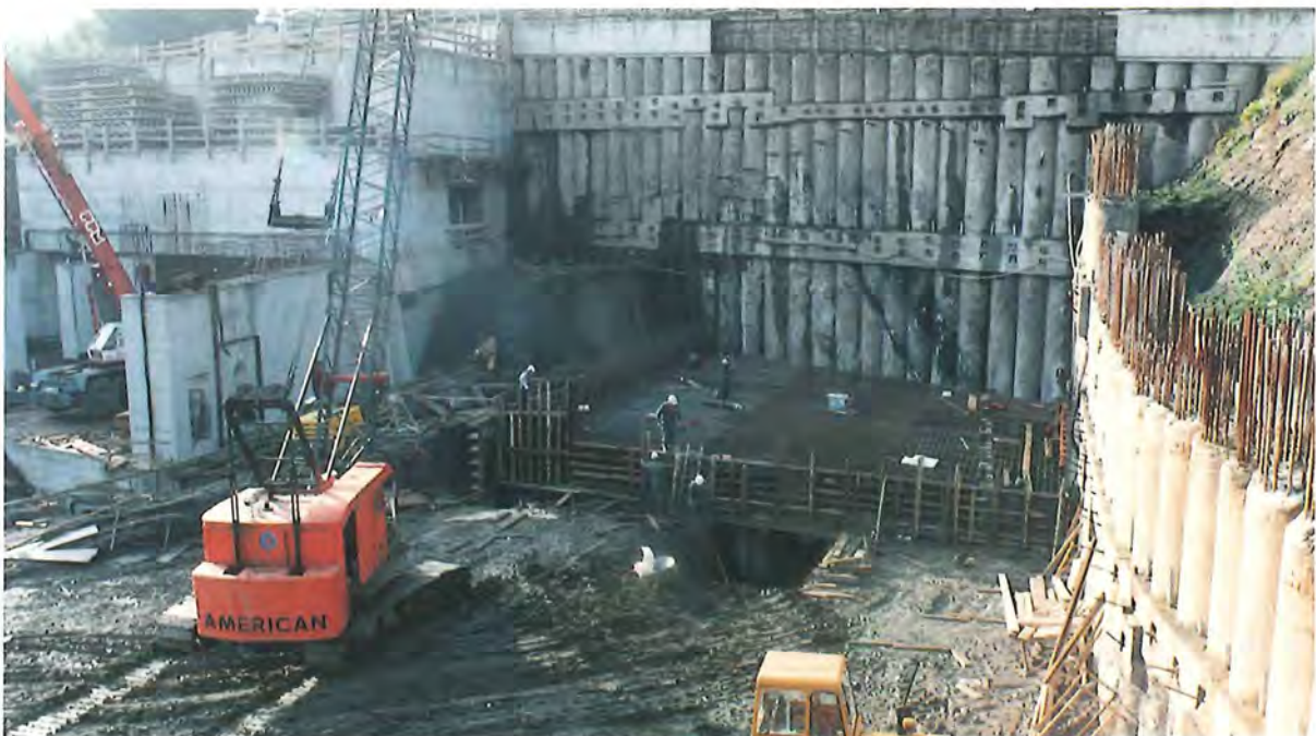
Figure 39 : les débuts de la construction de la tête « Guillemins », en 1988 • © Ex-MTP (n° 200 652)
