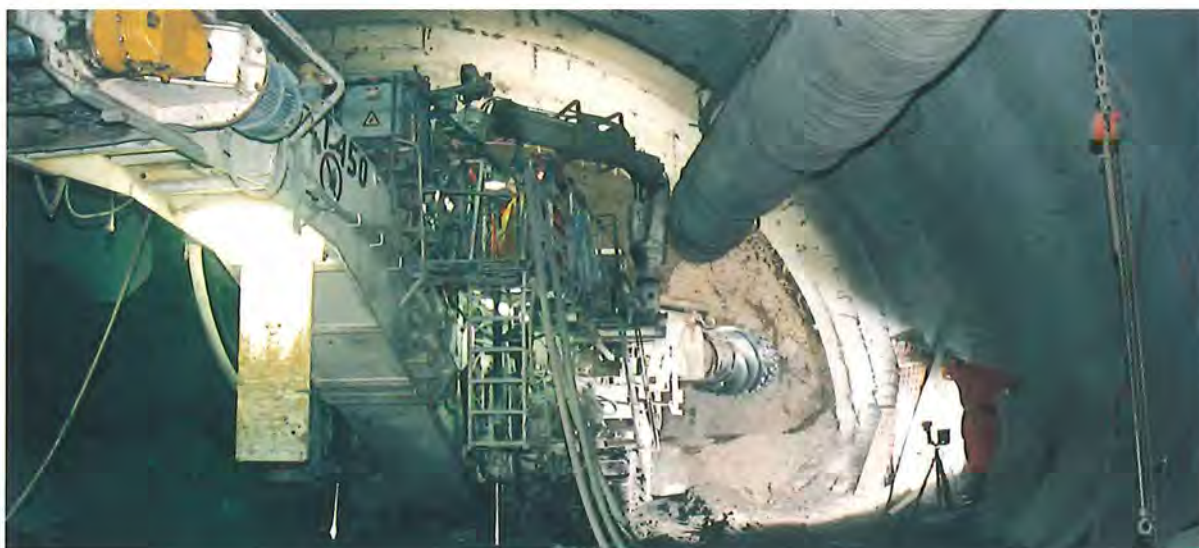
Figure 43 : la hacheuse en fonctionnement pour le creusement d'un des tunnels de Cointe, en 1995 (galerie pilote du tunnel amont) © A. Maréchal
