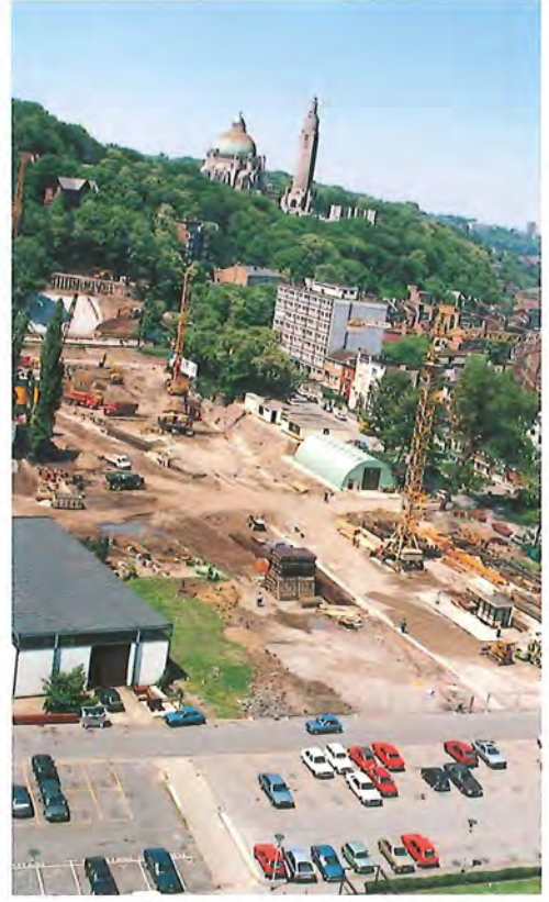
fig. 60 : le chantier en août 1986 • © A. Maréchal
