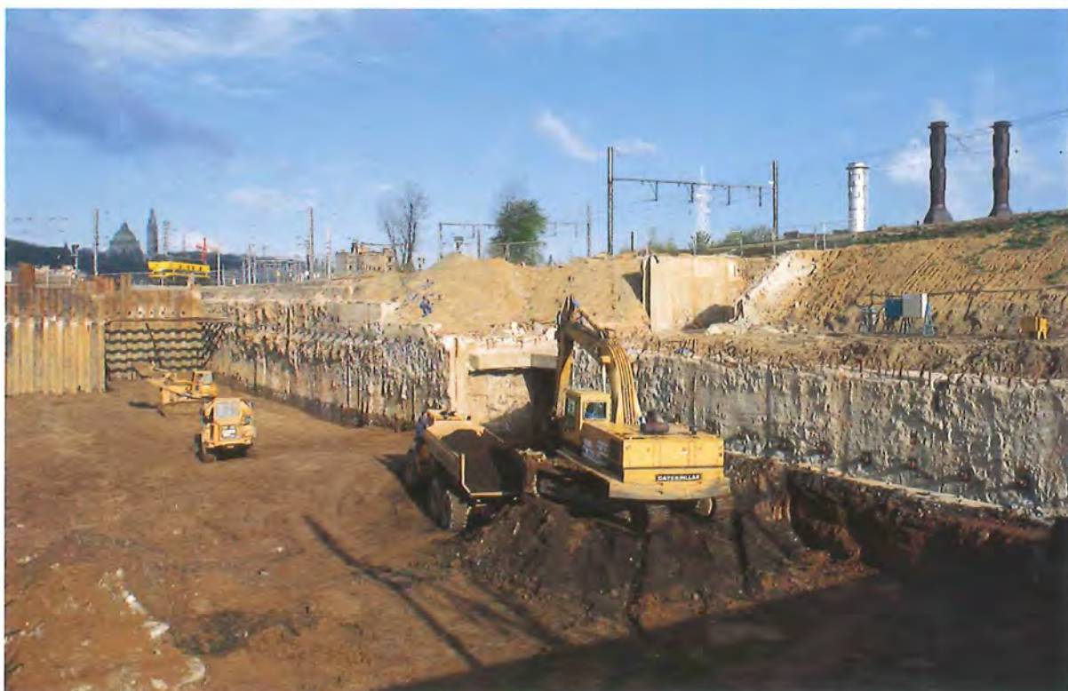
Figure 102 : les déblais ou excavations entre les parois moulées (phase 2), en avril 1997 • © Daylight
