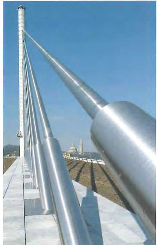
Figure 74 : détail de l'ancrage des haubans (mars 2000, vers Cointe) • © Daylight
