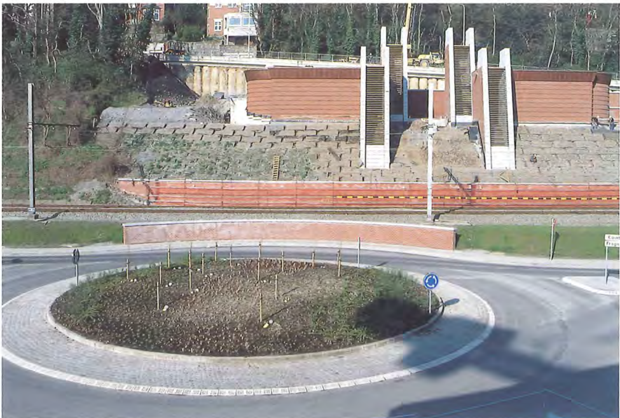
Figure 120 : les locaux de ventilation « Tilleuls », vus ici en mars 1999, avec l'échangeur à l'avant-plan, constituent une prise d'air frais pour les tunnels de Cointe. Une autre prise est située aux Guillemins. • © Daylight
