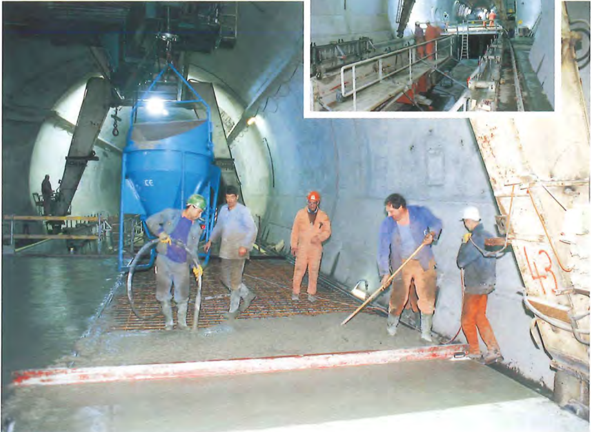
Figures 53 et 53' : réalisation de la dalle de route (vues d'août 1998) • © Daylight
