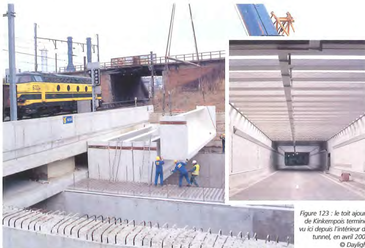
Figure 122 : pose des poutres préfabriquées, pour le toit ajouré de Kinkempois, en février 1998 • © Daylight
