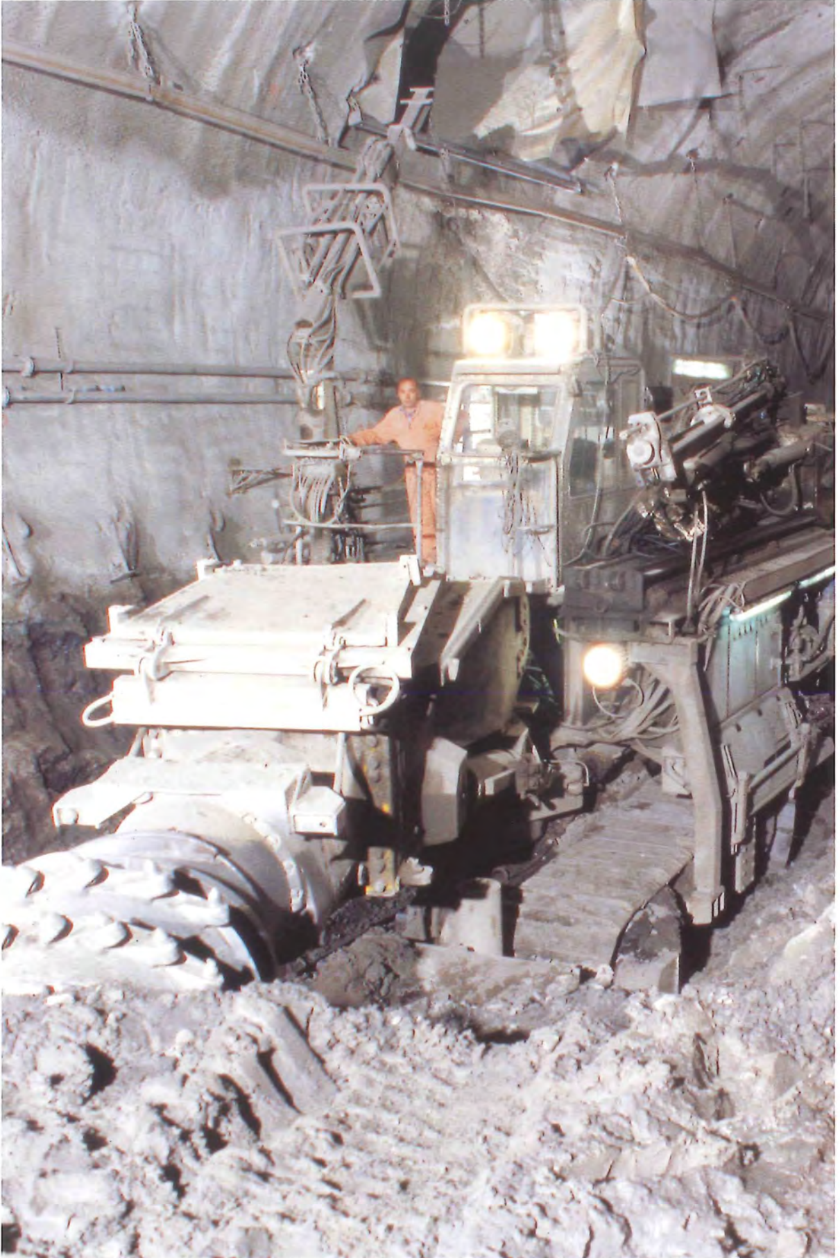
Figure 56 : le creusement sous la colline de Cointe, en juin 1998 • © Daylight
