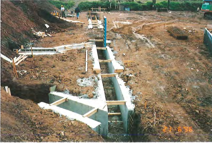
Figures 96 et 97 : la réalisation des parois moulées du tunnel de Kinkempois (phase 1) – Les murets-guides et les travaux d'excavation entre les murets (décembre 1997) • © V. Remy et Daylight
