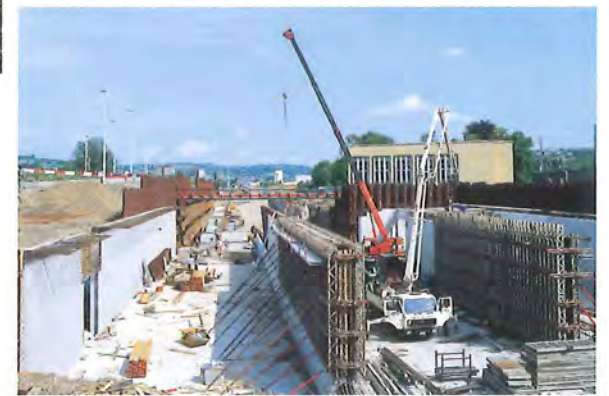
fig. 110 : le bétonnage de voiles (mai 1998) • © Daylight
