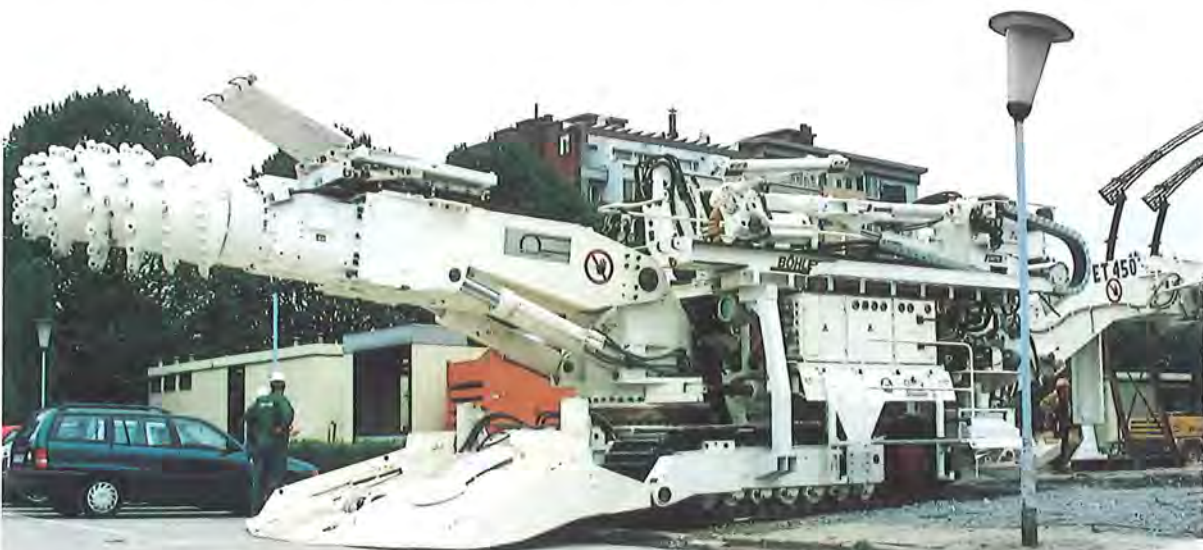
Figure 41 : la haveuse, qui sert au creusement des tunnels de Cointe • © A. Maréchal
