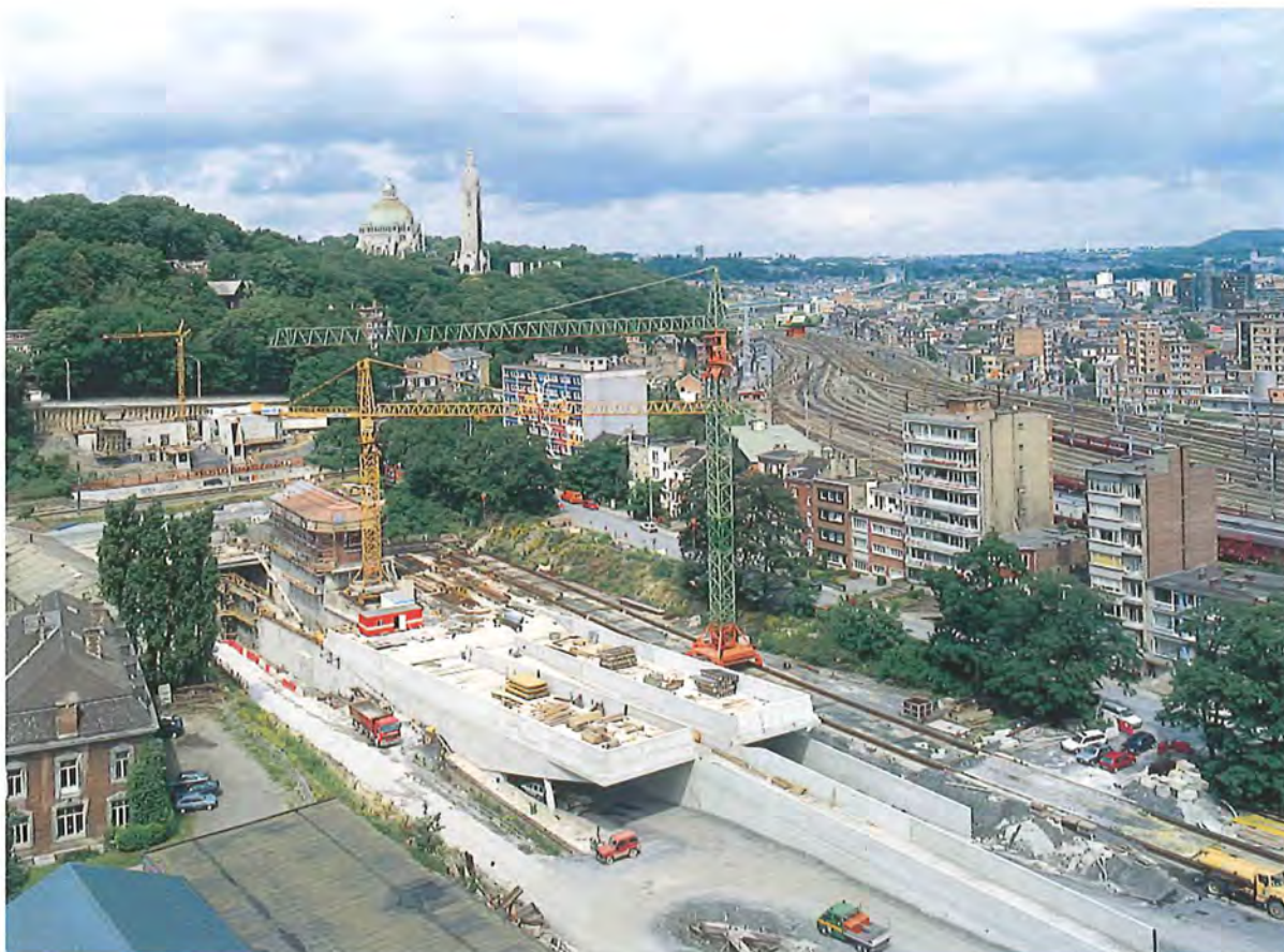
fig. 62 : le chantier en juin 1998 • © Daylight
