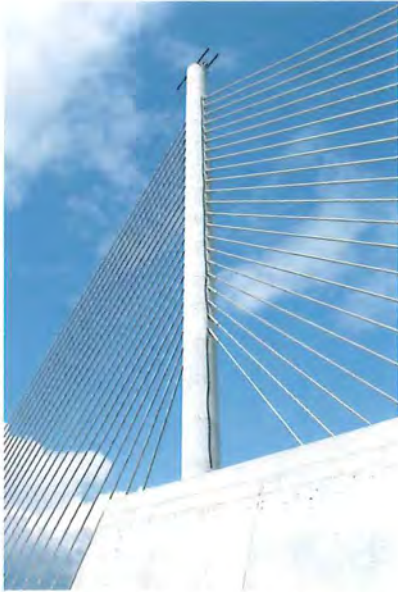
Figure 71 : le pylône du pont, de forme tronconique, s'élève à 75 mètres de haut (vue d'avril 1999). • © Daylight
