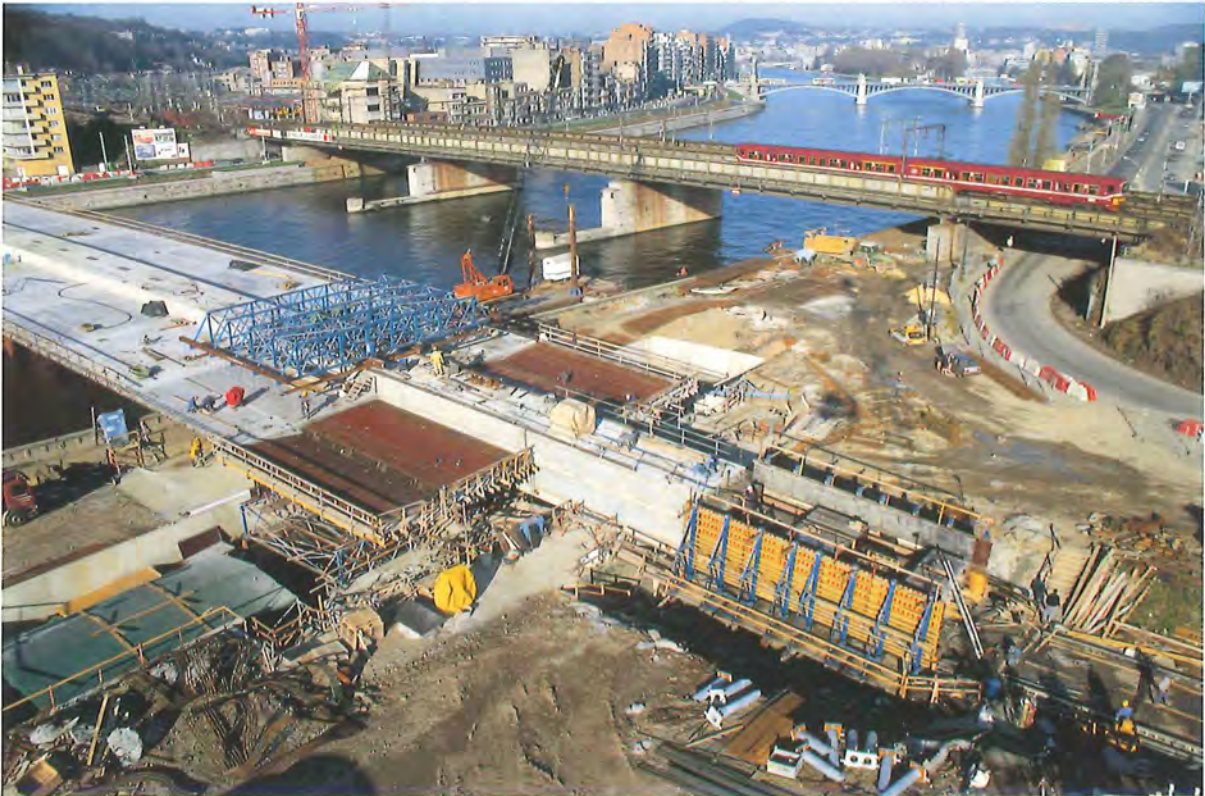
Figure 83 : l'aire de préfabrication du tablier en rive droite, séparée en quatre zones (vue d'octobre 1997) • © Daylight
