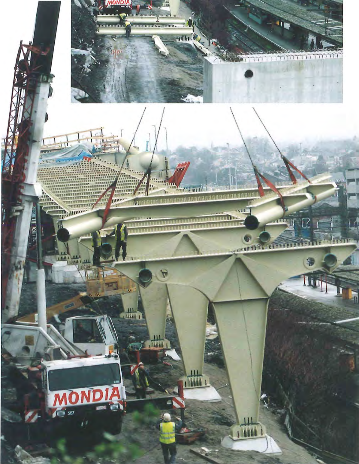
Figures 32 et 33 : montage du viaduc d'accès à l'arrière de la future gare TGV, entre le flanc de la colline de Cointe et les voies ferrées – Les ensembles longrines-entretoises, préassemblés au sol, sont hissés, au moyen d'une grue, et positionnés entre les piles (janvier 2000) ; à l'arrière-plan, on distingue l'autoroute, qui descend vers les tunnels de Cointe. • © D. 434 (n° 00/28 et 00/39)
