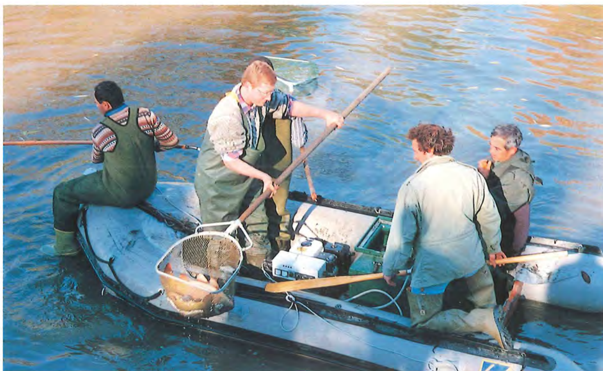
Figures 10 et 11 : exemples de mesures environnementales prises pendant les travaux – Les déblais ont été évacués par la voie d'eau, et, avant la mise à sec du canal de l'Ourthe, les poissons ont été capturés par pêche électrique et réintroduits après les travaux. • © J.-P. Roland et V. Remy
