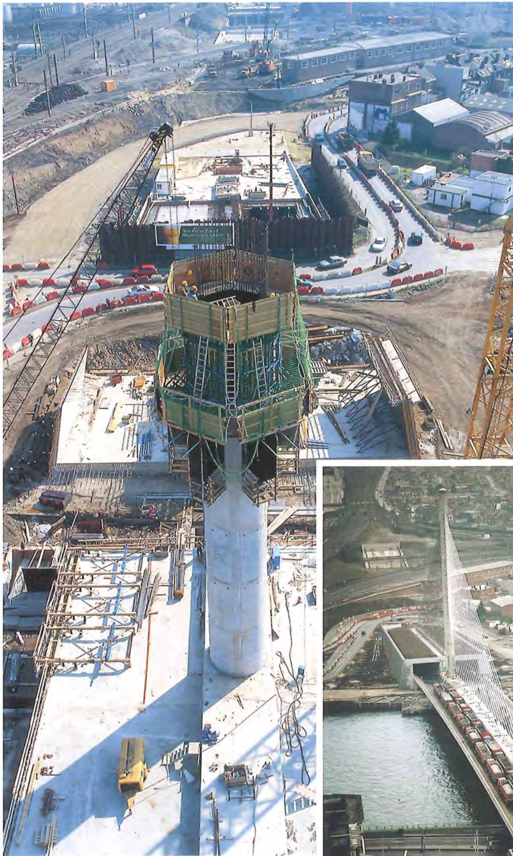
Figure 78 : le nouveau pont en construction, en mars 1998 – Réalisation du pylône et de la culée-contreponds ; à l'arrière-plan, on distingue le chantier du tunnel de Kinkempois. • © Daylight
