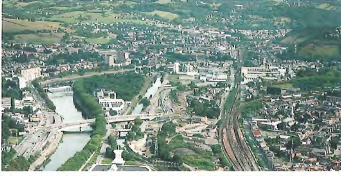
fig. 108 : le chantier des Grosses-Battes à ses débuts, en décembre 1997 © D. 434 (n° 97/3945)
