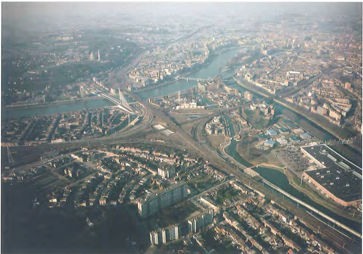
Figure 2 : la liaison E40-E25, véritable autoroute urbaine, fait disparaître l'un des maillons manquants du réseau routier européen – Au centre, le quadrilatère ferroviaire et le pont sur la Meuse ; à l'arrière-plan, la colline de Cointe et l'élargissement des voies de chemin de fer qui s'engagent dans la gare des Guillemins ; dans le fond, la jonction avec l'A602 (vue prise au-dessus des Grosses-Battes en janvier 2000) • © D. 434 (n° 00/145)
