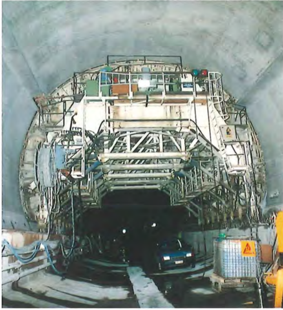
Figures 51 et 52 : ces deux figures illustrent très bien l'adaptation latérale nécessaire du portique de bétonnage dans une section élargie, illustrée sur la photo de droite (vues d'août 1998). • © A. Maréchal et Daylight
