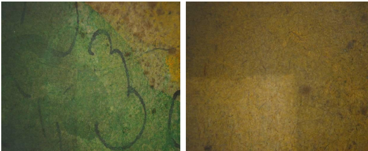
Die Oberfläche vor und nach der Reinigung mit dem Raderschwamm
