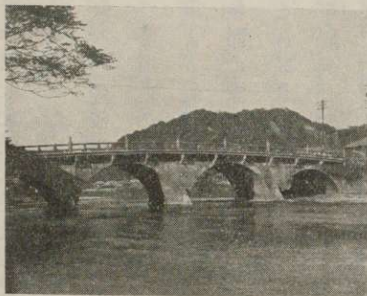
第三十圖 鹿兒島西田橋 (全長四九・九米 弘化三年九月竣功)
