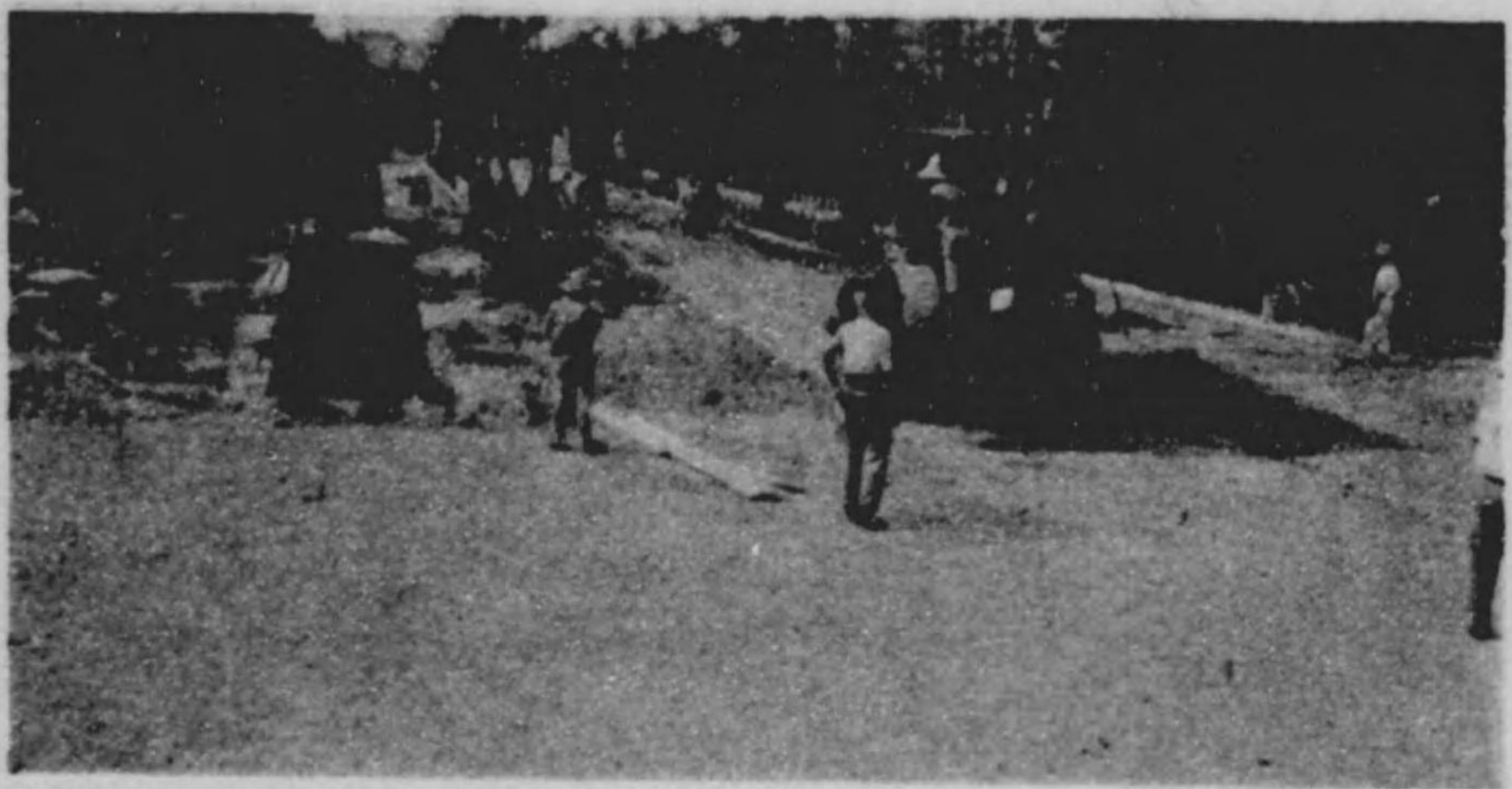
道路補強工事の状況
