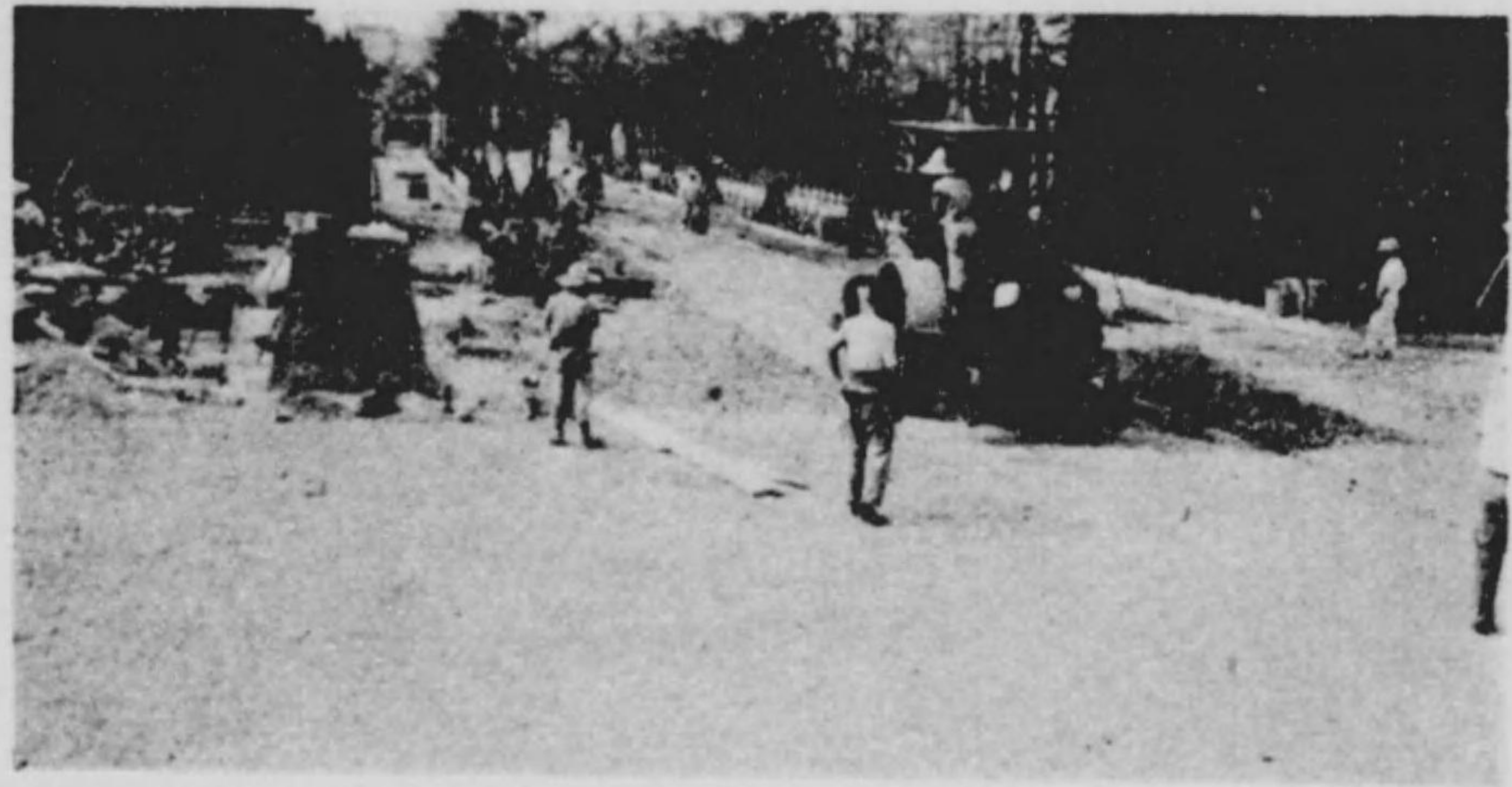
道路補強工事の状況
