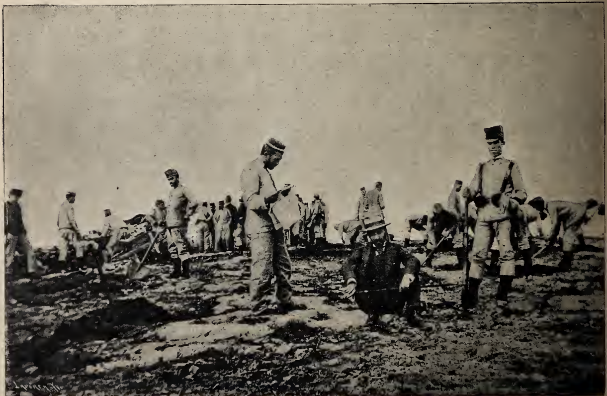
TRABAJOS DE ATRINCHERAMIENTO EN HORCAS COLORADAS.—FOTOGRAFÍA DE COMPAÑY
