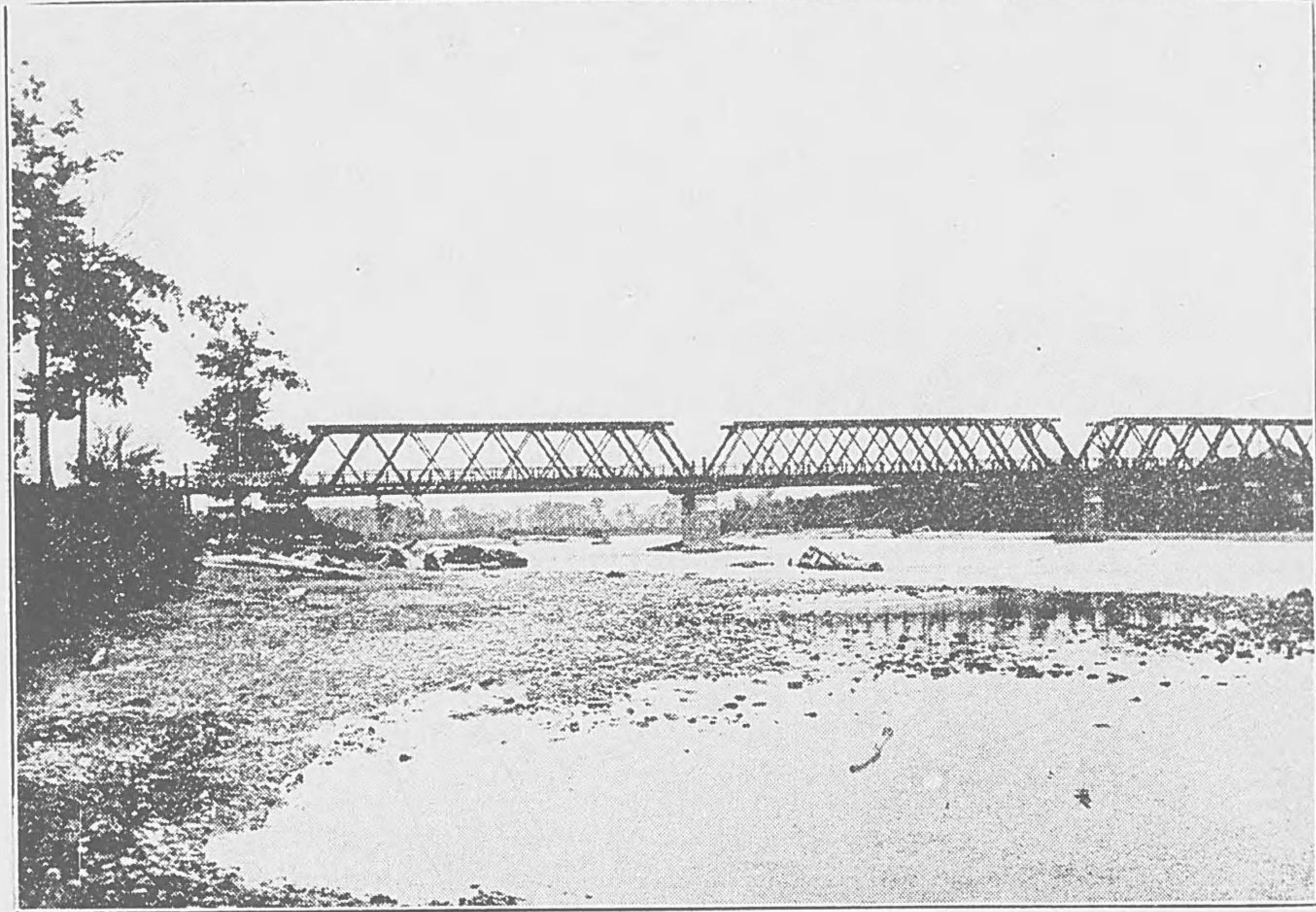
The Sorachuputo bridge, Ishikari.
