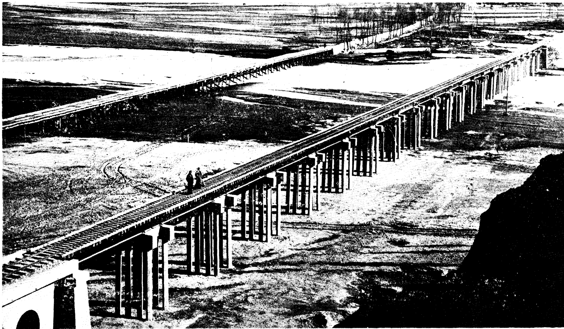
此橋河底係土砂故採用鋼筋混凝土排樁代替墩架上架九點七五公尺之工字鋼梁全長二百一十六公尺 於二十三年十一月落成
