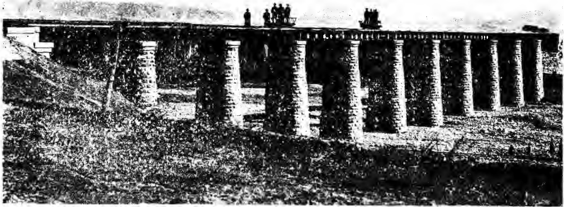
於墩橋上凝混皮石料用採尺公五一點五十九長全孔一十分計橋梁鋼字工之尺公五六點八係橋此 成告底月七年三十二
