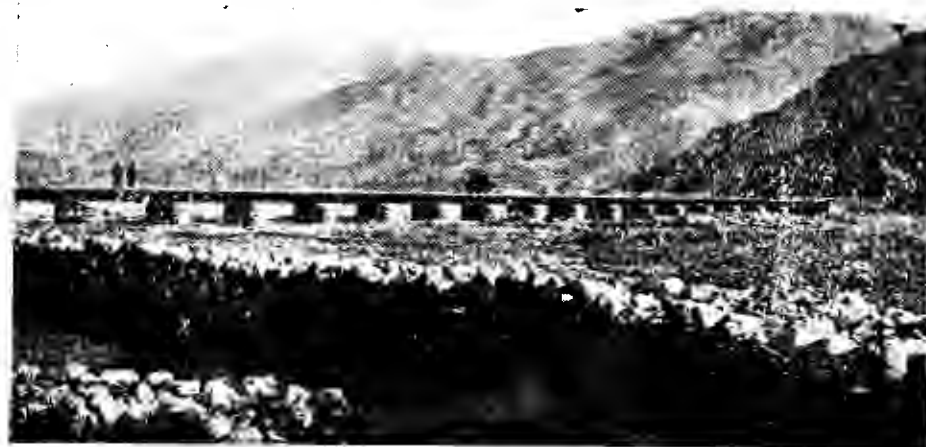
上：南工第七分二段四孔公尺之斜旋橋填土情形 下：靈石村溝橋用公尺三點六字鋼梁九十孔
