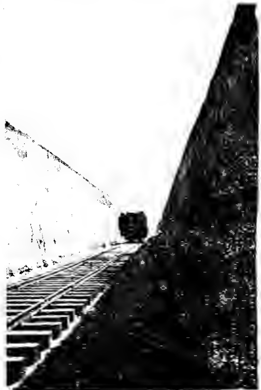
鋪新中方挖近附里公十二段北 性立豎之質土西山見可線路
