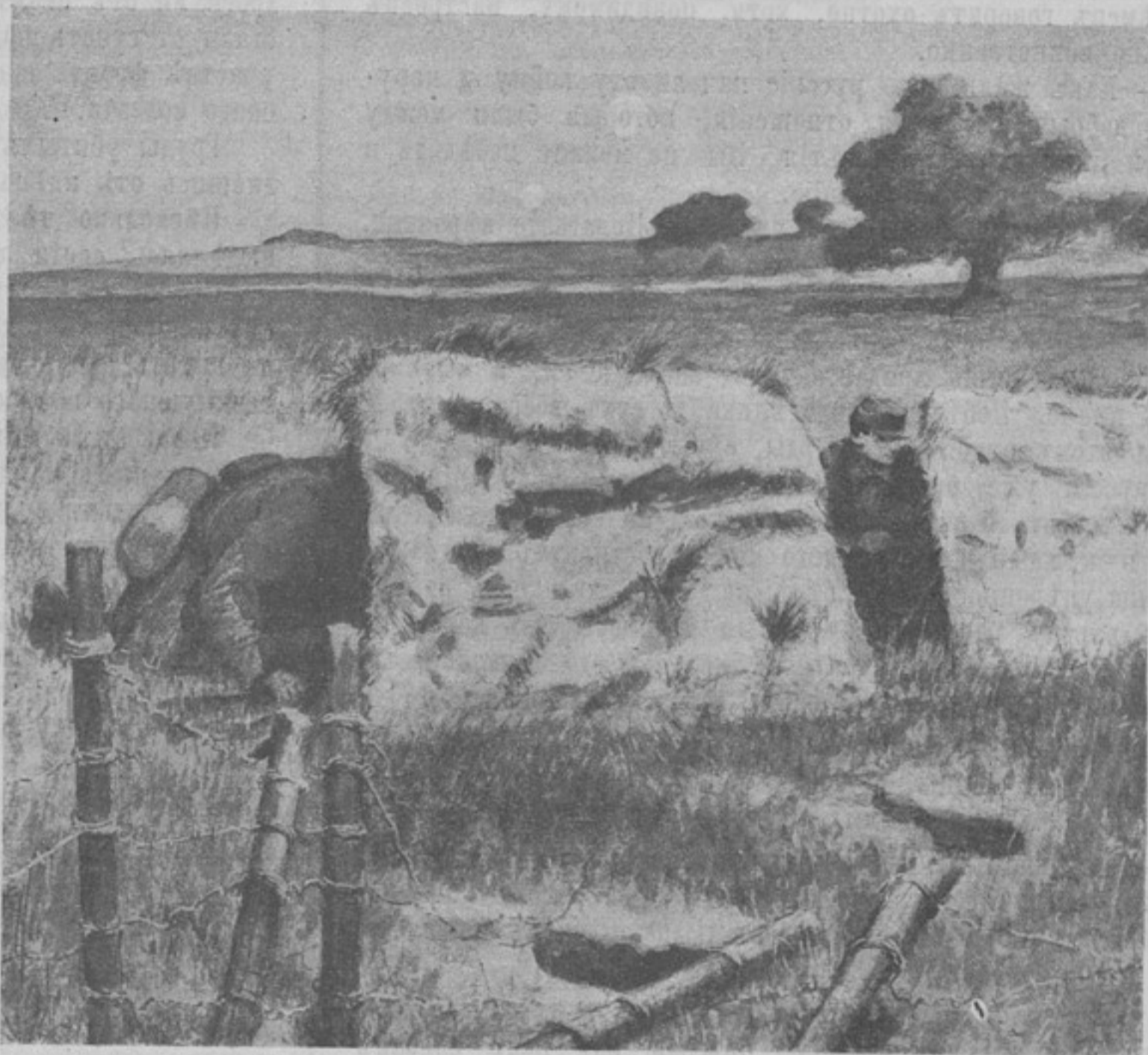
Стальные щиты, окрашенные въ защитный цвѣтъ и замаскированные тлавою, примѣняемые французами. („The Ill. London News“)
