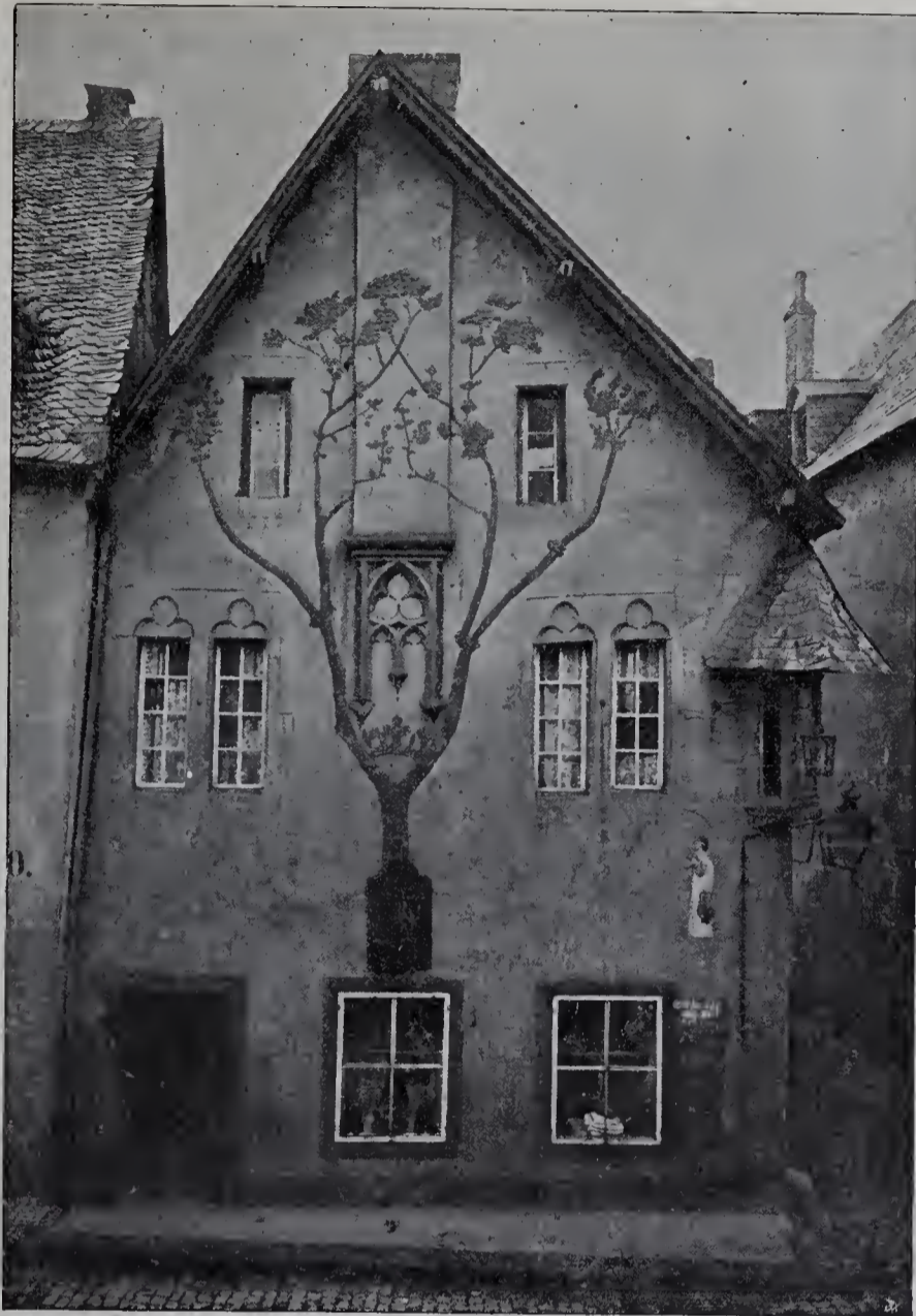
Wohnhaus in Trier, Webersbachstrafse 61.
