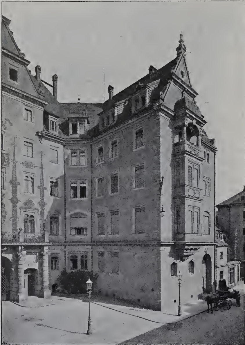
Vereinshaus und Hospiz für innere Mission in Dresden, Zinzendorferstrafse 17. Architekten: Schleinitz und Flügel, Dresden. 1. Flügelbau. (Zu Tafel 69 und 70 im Hauptblatt.)
