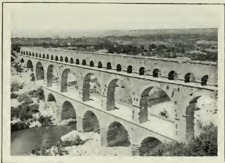
FIG. 126. — VUE DE L'AQUEDUC ROMAIN DIT LE « PONT DU GARD ». (Cliché Neurdein.)
