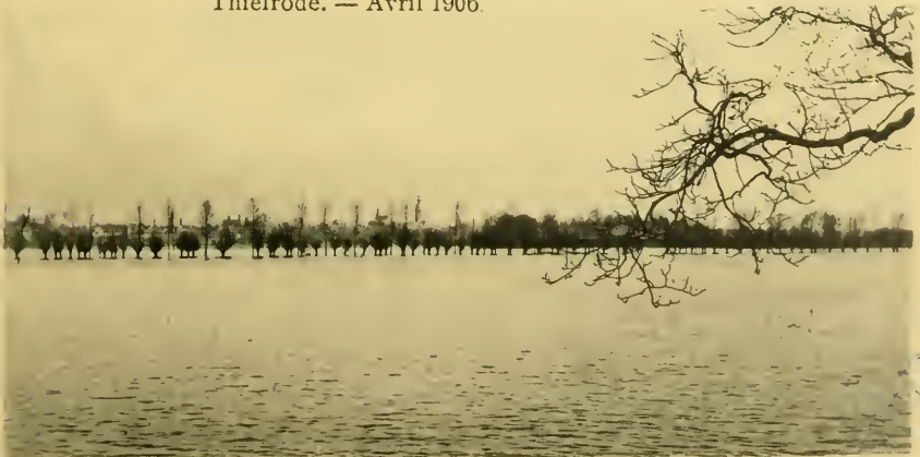
Phot. 70. Polder de Thielrode inondé. — Avril 1906.
