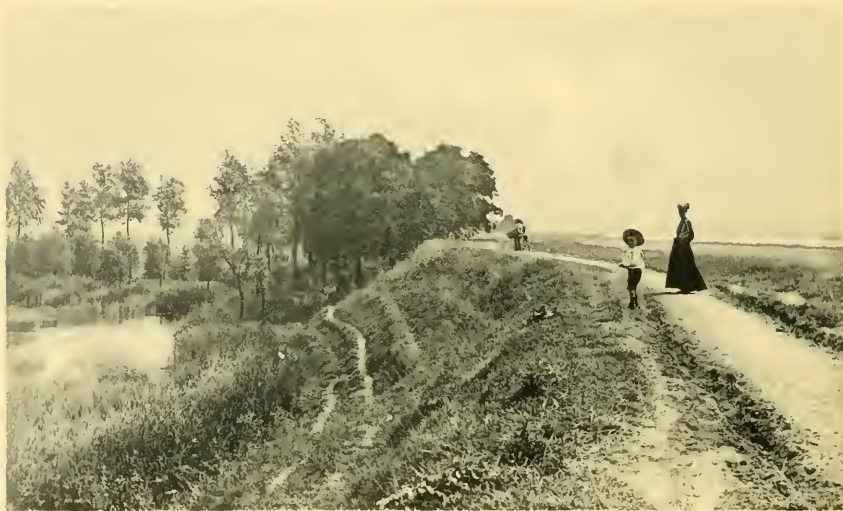
Phot. 65. Digue de l'Escaut, à Burght. — Juin 1904.
