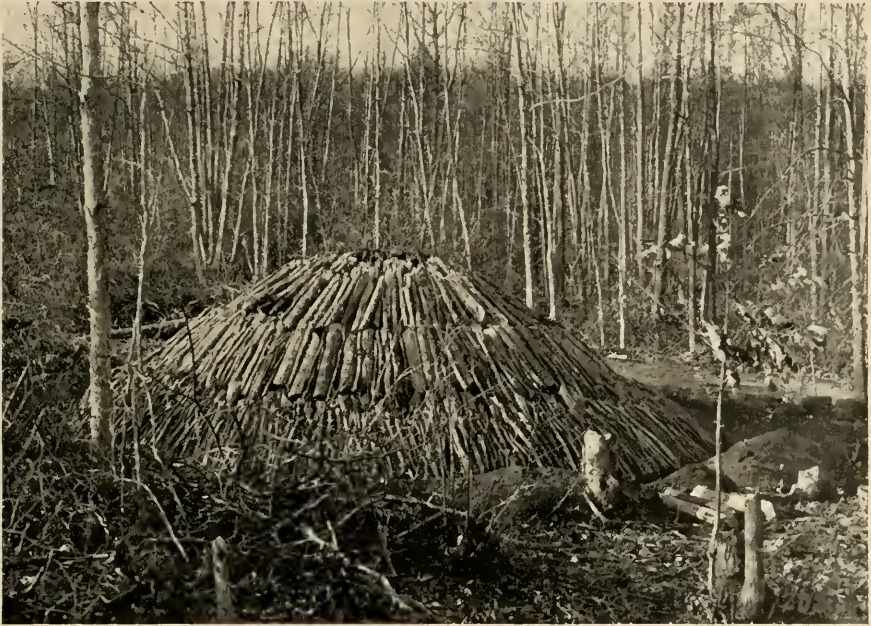
FIG. 1.—MAKING A KILN.
