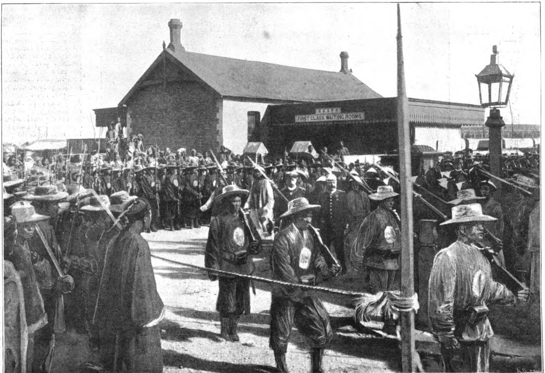
TIEN-TSIN. — TROPAS REGULARES CHINAS EN LA ESTACIÓN DEL FERROCARRIL. LOS SUCESOS DE CHINA. (De fotografías.)
