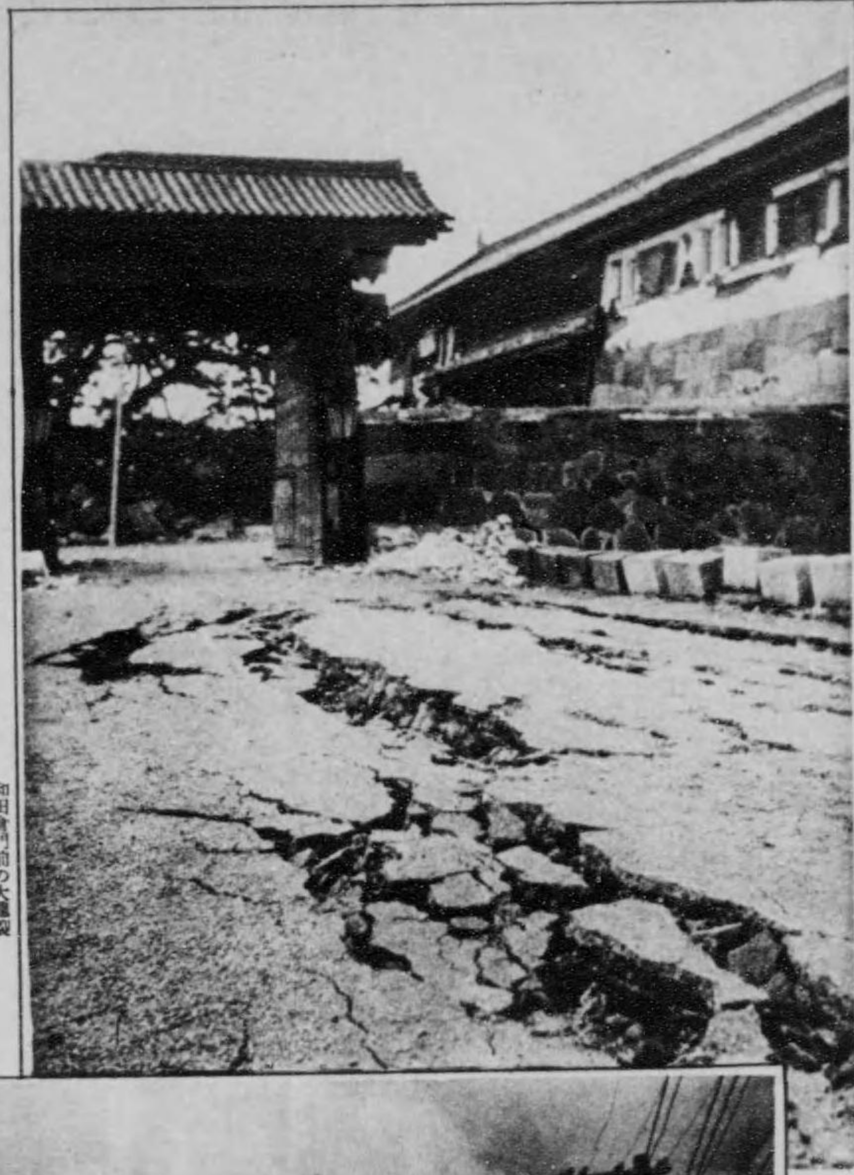
和田倉門前の大亀裂
