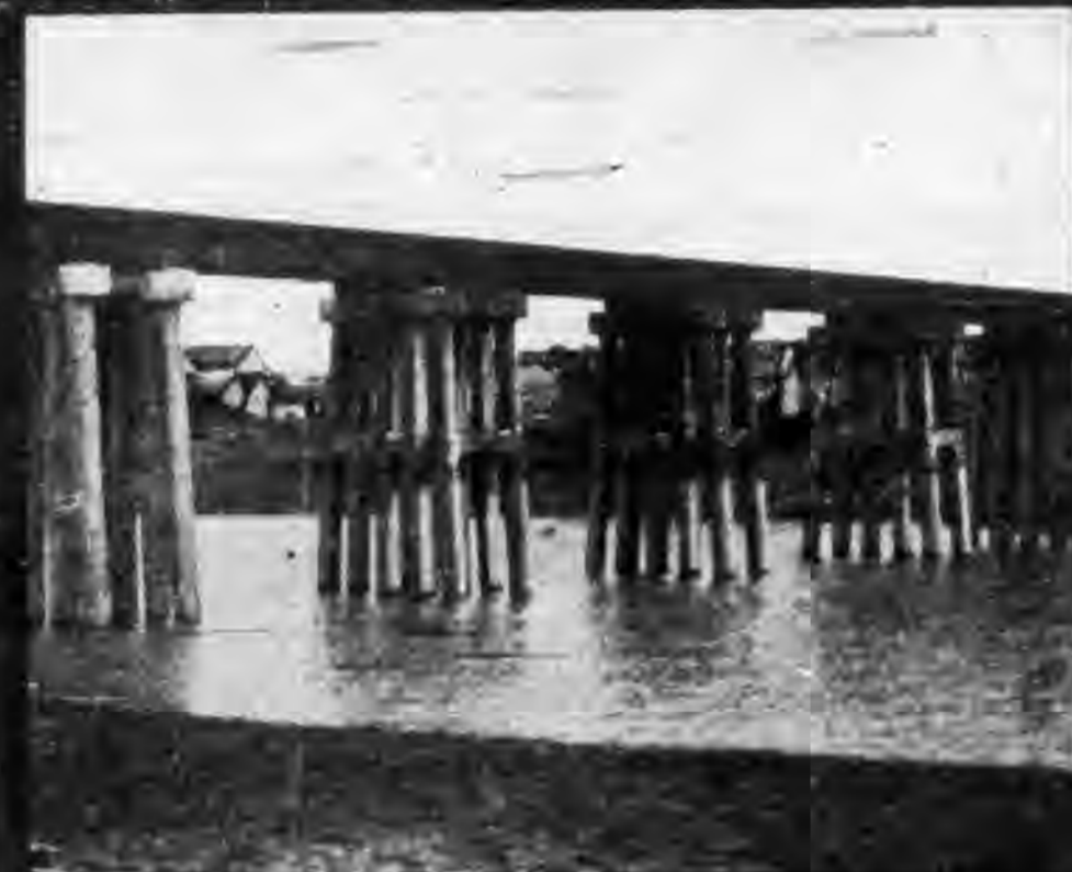
←之大鐵橋。段雨花路秦淮河橋一段新建路之中央聯絡線。圖為其南溝通江南鐵路與京滬津浦等
