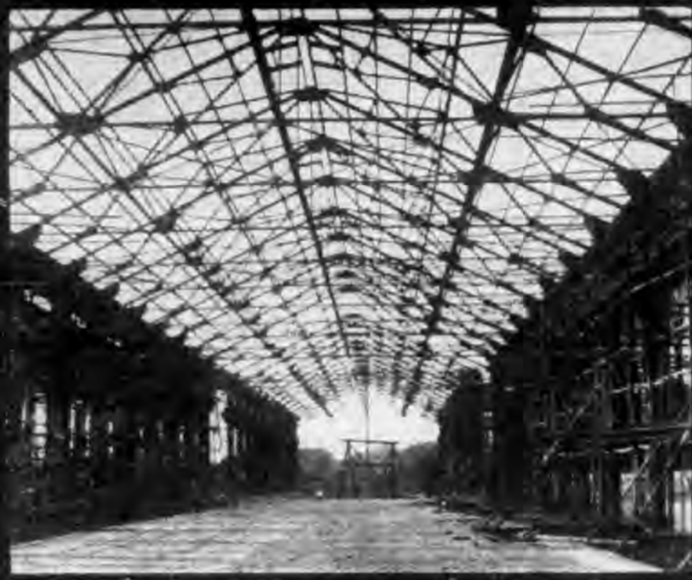
←在建築中之中央機器廠內部情形。
