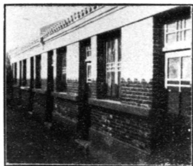
建築第八區平民住宅工程完成後房屋正面情形
