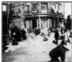
修築北馬路礮基礎石澆油路工程墁磚基情形
