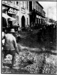
修築海大道礮石路面工程 平墊道胎情形
