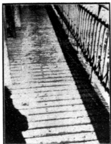
修理金湯橋橋板工程 工竣復情形
