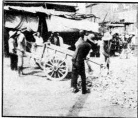
修築海大道礮石路面工程 裝運礮石情形
