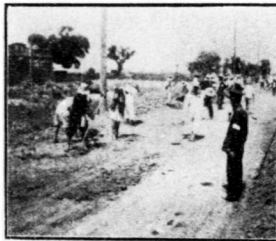
修築海大道壩灰路面工程 起修道胎情形之一
