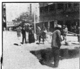
修葺大胡同礮石潑油路面 工程潑油後鋪撒末礮情形
