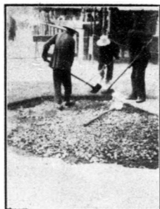
修補北門外大街炒油路面工程鋪置炒油情形
