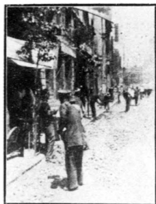
修補東馬路瀝青路面工程 原有路面損壞情形
