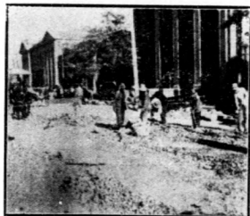
翻修特三區大經路礮石澆油路工程創起舊礮情形
