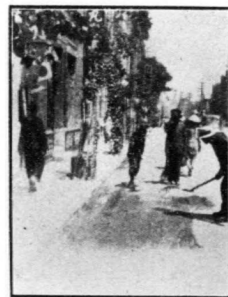
修補東馬路瀝青路面工程 瀝青油情形
