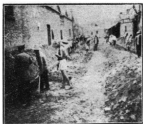
修築南市福安大街磚基礮石 瀝油路工程起修道胎情形
