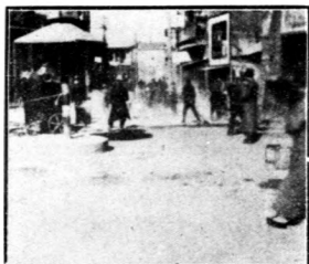
修築北馬路礮基礮石澆油路面工程澆油情形
