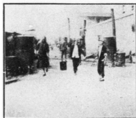
修築南市福安大街磚基礮石 瀝油路工程熬油情形
