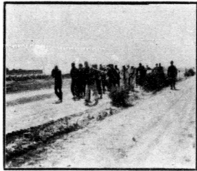
修墊萬國馬場道爐灰路面工 程用人力軸碾軋路面之一
