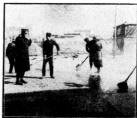
翻修沿河馬路礮石澆油路面工程澆油情形
