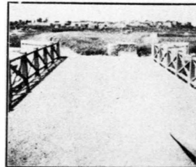
修理紀家莊大橋工程 工竣復情形之二
