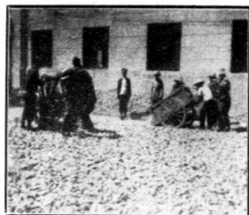
翻修特二區平安街礮石路面工程工作情形之二
