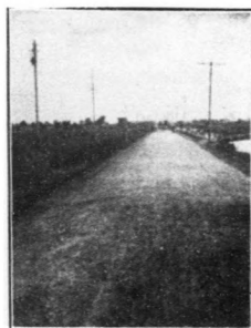
修築八里台大道礮石路面 工程工竣後情形之一
