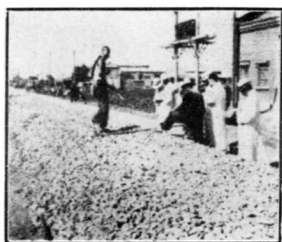
修築八里台大道礮石路面工程驗收礮石情形
