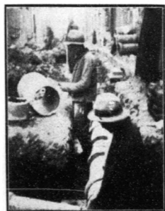
修築襪子胡同時溝工程 安裝缸管情形
