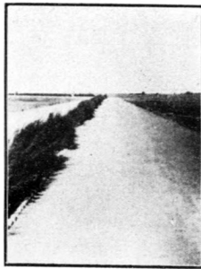
修墊萬國馬場道爐灰路 面工程路面完成之情形
