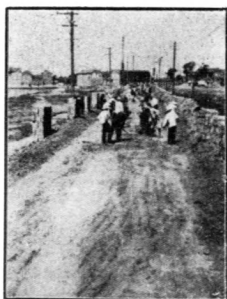
修築海大道爐灰路面工 程起修道胎情形之二
