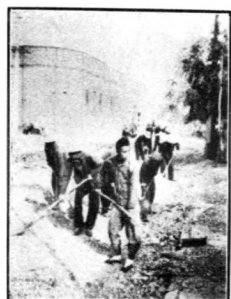
翻修特三區二緯路礮石潑 油路面工程創做道胎情形
