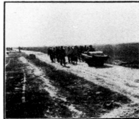
修墊萬國馬場道爐灰路面工 程用人力軸碾軋路面之二
