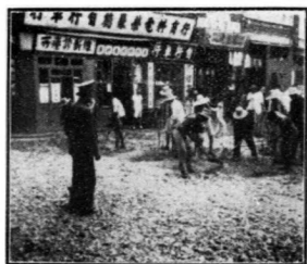
修築水閣大街礮石潑油路面工程創道胎及鋪礮石情形
