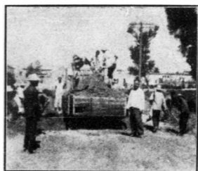
修築海大道爐灰路面工 程運輸爐灰情形
