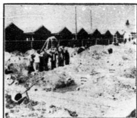
建築第七區平民住宅工程 打灰土情形之二
