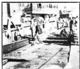
修理金華橋橋板工程拆除 舊有橋板情形
