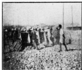
修築八里台大道礮石路面工程鋪礮石情形
