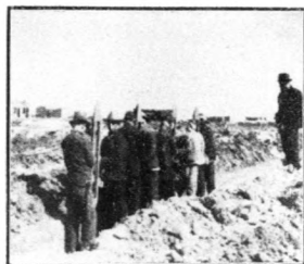
建築第六區平民住宅工程 打灰土情形
