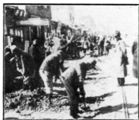
修築北馬路礮基礎石澆油路面工程刨道胎情形
