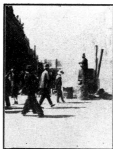
修葺大胡同礮石潑油路面 工程熬油工作情形
