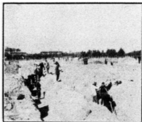
建築第六區平民住宅工程創槽情形
