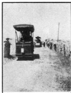
修築海大道爐灰路面工 程汽碾碾壓情形
