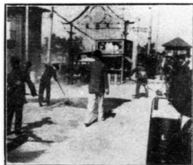
修葺大胡同礮石潑油路面 工程潑油情形
