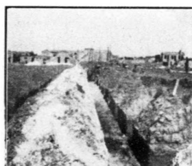
建築第七區平民住宅工程 創槽情形
