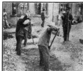
修葺大胡同礮石潑油路面 工程修做過街溝情形
