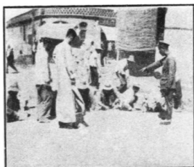
修築南市福安大街磚基礮石 瀝油路工程鋪墁磚基情形
