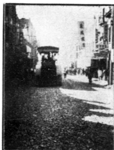
修葺大胡同礮石潑油路面 工程汽碾碾軋路面情形
