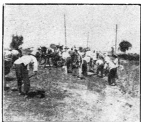
修築海大道爐灰路面工程 鋪築爐灰情形
