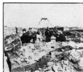
建築第七區平民住宅工程 打灰土情形之一
