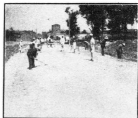
修築海大道爐灰路面工 程平整道胎預備磚基情形
