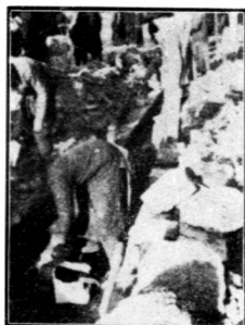
特三區大經路改修缸管暗溝施工情形之二
