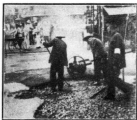
修補北門外大街炒油路面工程用火軸碾壓情形
