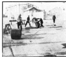
修補特三區四緯路炒油路工 程鋪炒油及用火軸碾軋情形
