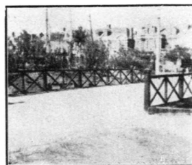
修理特一區海寧路木橋 工程欄杆工竣側影
