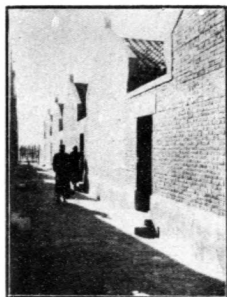
建築第七區平民住宅工 竣後胡同內之一瞥
