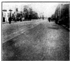
翻修特三區一緯路礮石潑 油路面工程工竣後情形
