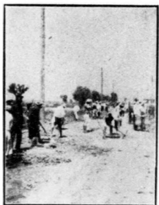
修築八里台大道礮石路面工程創道胎情形
