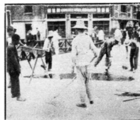
修理特一區海寧路木橋 工程工竣後情形
