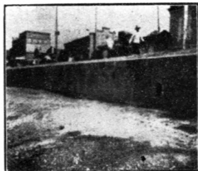
修理南運河大王廟對過之磚 壩工程工竣復情形
