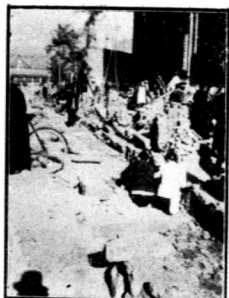
特三區大經路改修缸管暗溝施工情形之一
