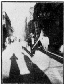
修築水閣大街礮石潑油路面工程工竣後情形
