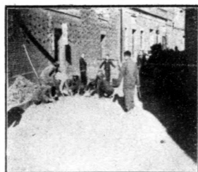
修葺襪子胡同磚基礮石 潑油路工程埋磚情形
