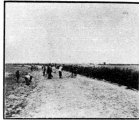
修墊萬國馬場道爐灰路面工 程由路旁取土平整路面情形
