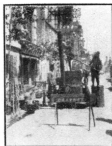
修補東馬路瀝青路面工程 熬瀝青油之情形
