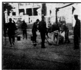
翻修特三區一緯路礮石潑 油路面工程潑油情形
