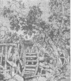
老水車，是農村中一種古老的灌溉工具，它利用水流的動力，將水提升到田間。
