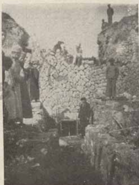
→ 拆卸城垣建築涵洞狀況
