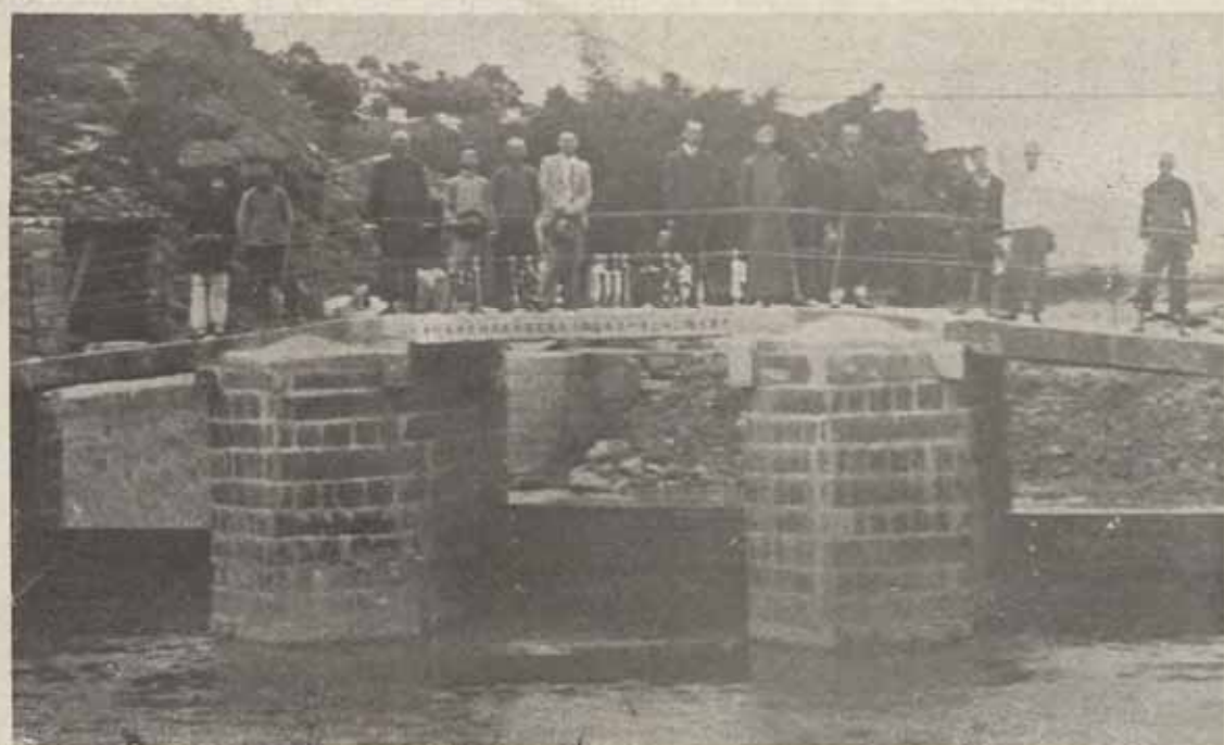
茅川陡門建築工竣之攝影
