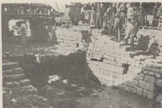
→ 破壞不堪之東門陡門
