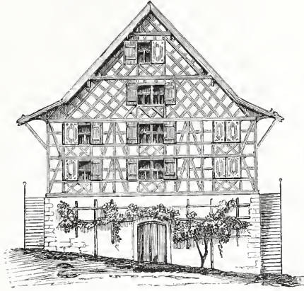
Ständerbau mit Riegelwand. (Beudliton.)
