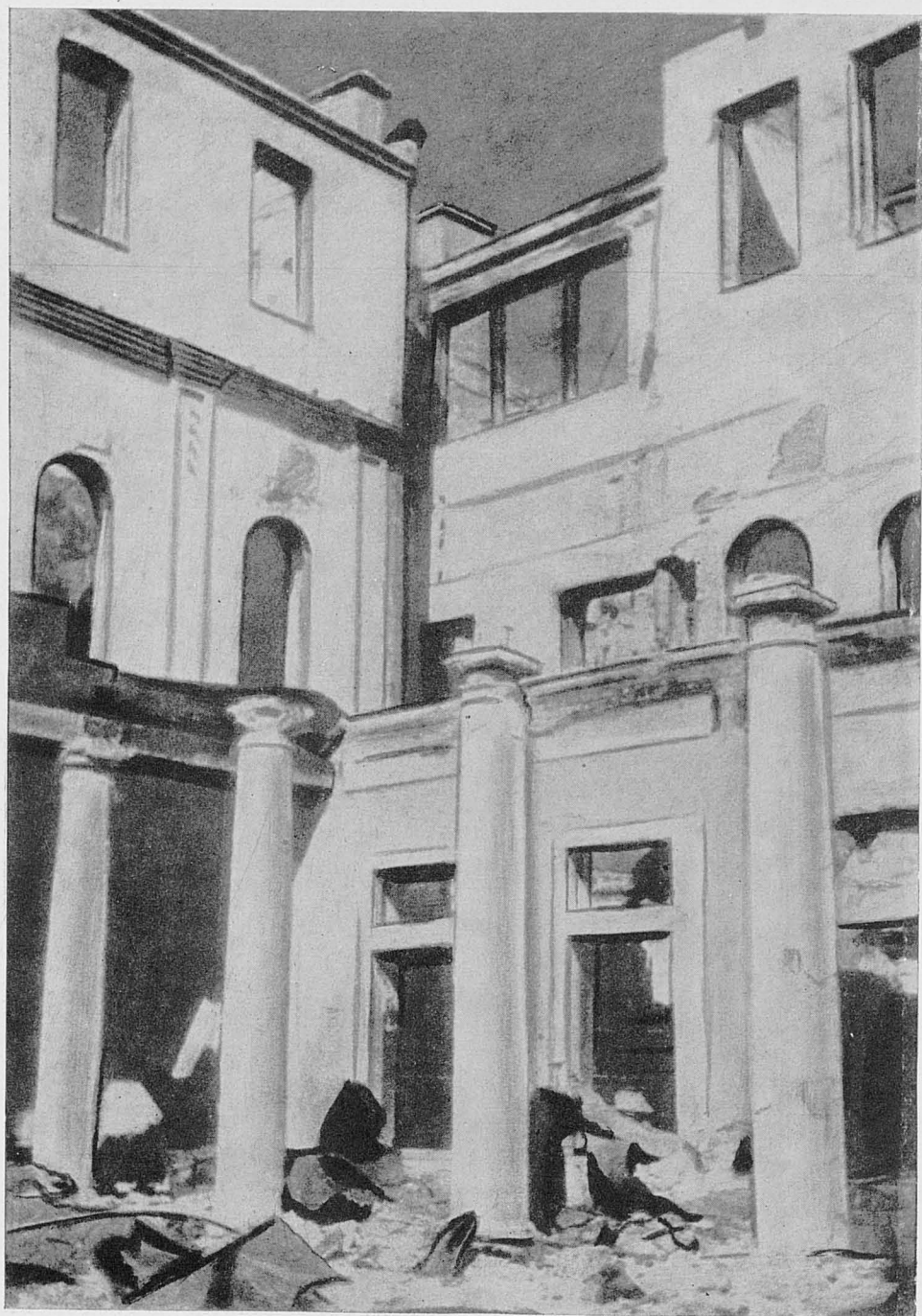
Разрушенный Дворец пионеров в г. Харькове.
