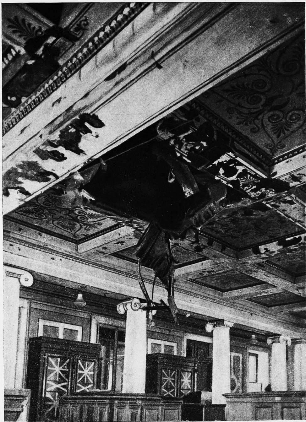
Разрушения в Государственном Эрмитаже в г. Ленинграде.
