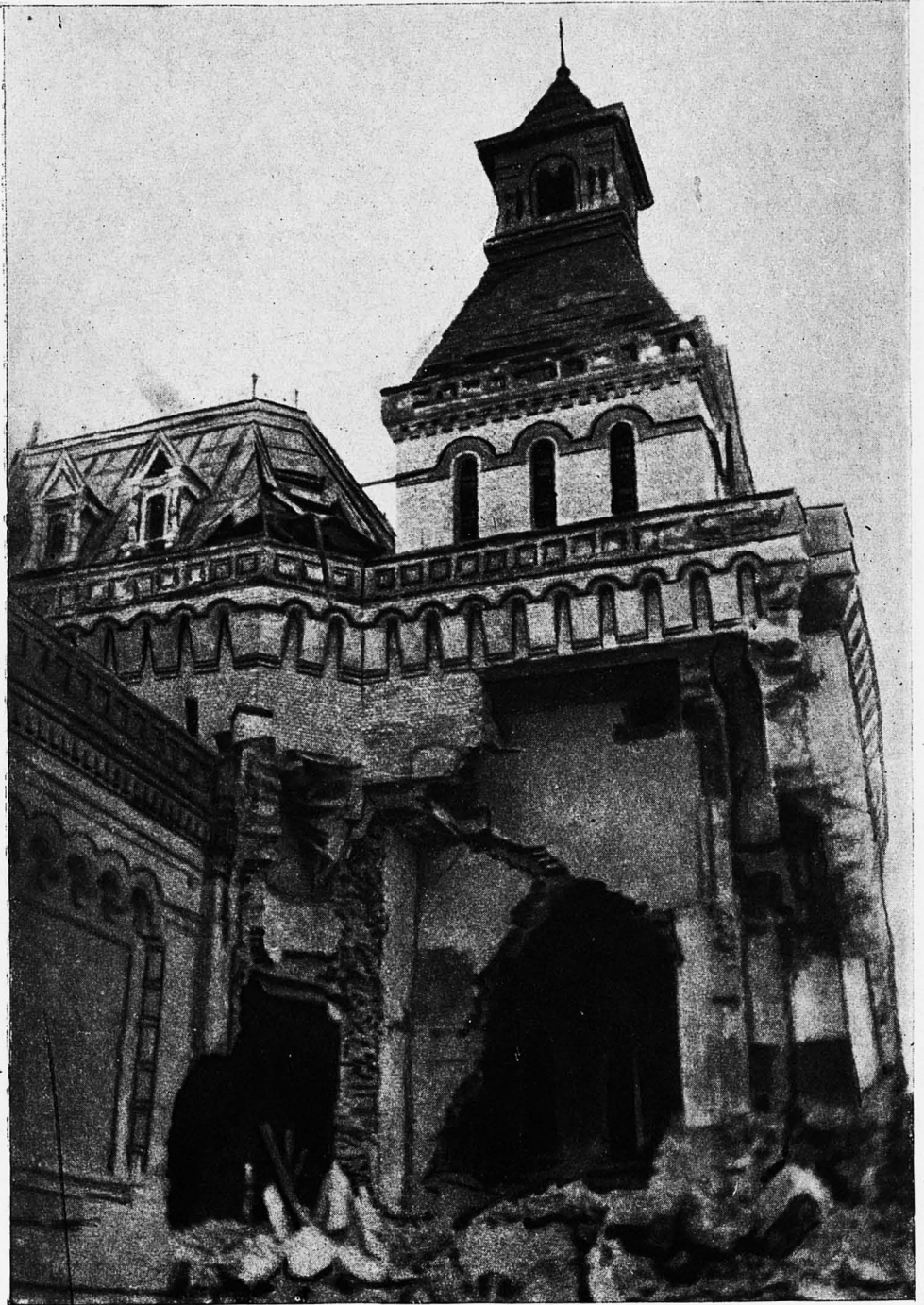
Разрушенное здание Суворовского музея в г. Ленинграде.
