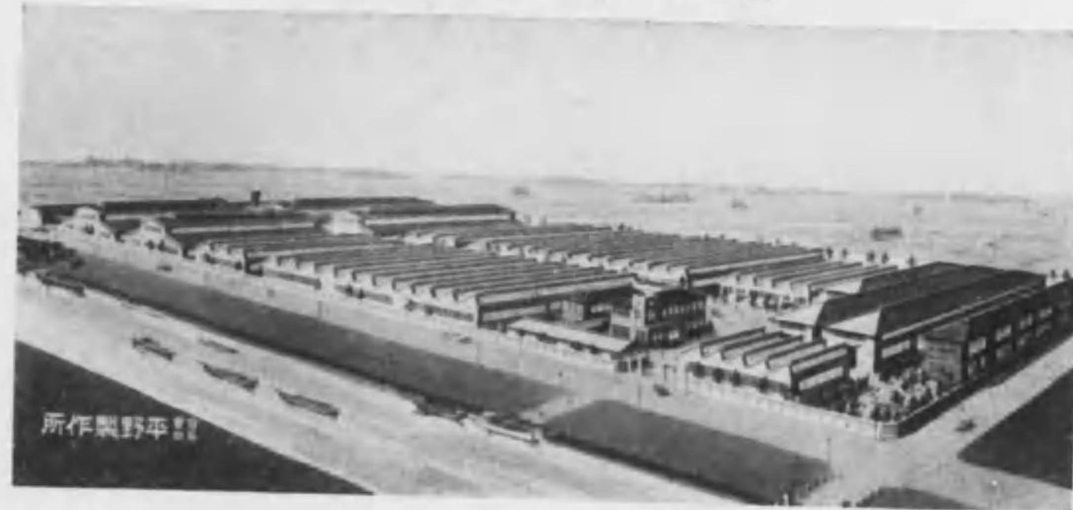
中川工場全景
