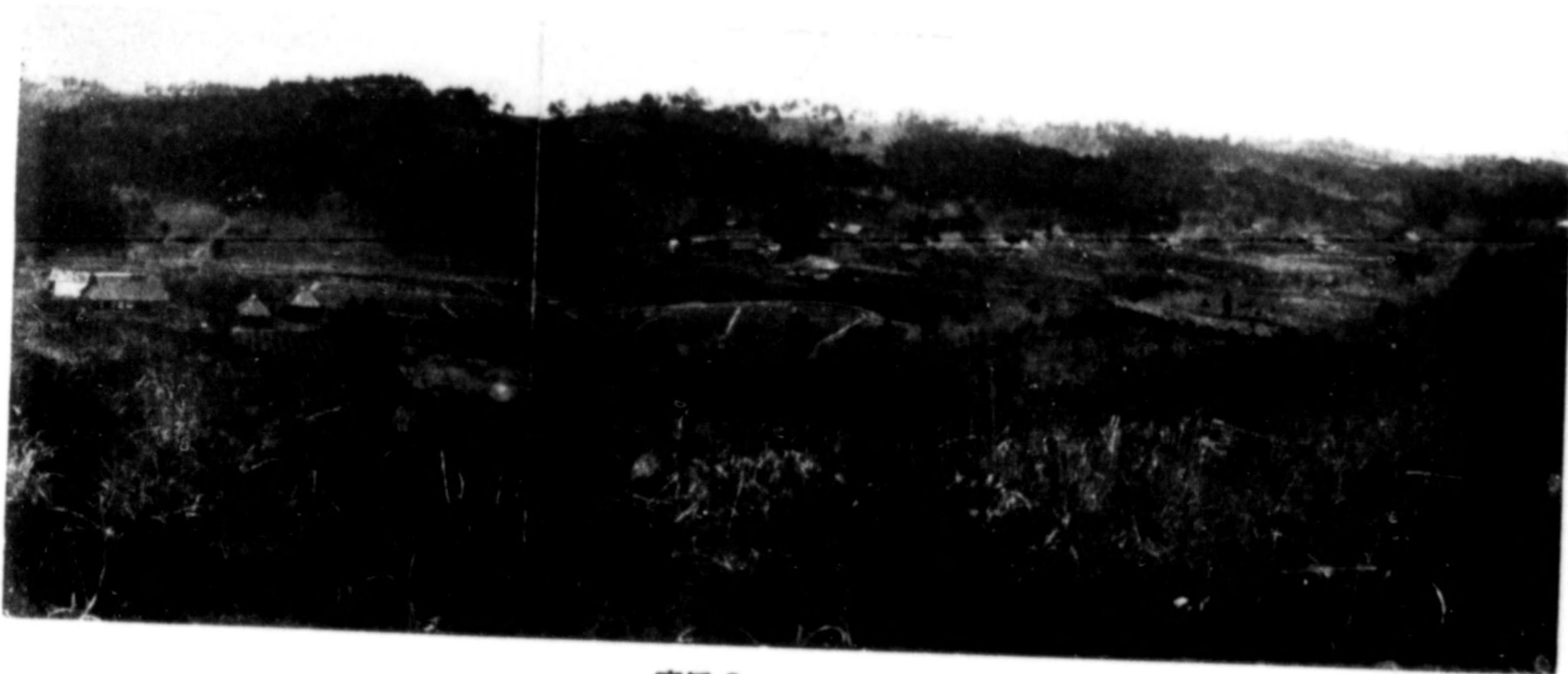
寫眞2、工 事 着 手 前 に 於 ける 山 出ずして早くも工事に着手するの運びに到達 し、爾來工を進むるに鋭意努力し、幸ひにし て施工上さしたる障害に遭遇することなく、 略豫定の工程をたどりて昭和7年10月中旬に は本貯水池に通水を始めんとする迄に立ち到 つたのである。而して本貯水池全體の竣功を 遂ぐるのは、昭和8年3月末の見込であるが、 主要工事は大體既に出来上つても居り、今や 將に通水を始めんとするに當つて、本貯水池 工事の概況を述べんとするのである。
