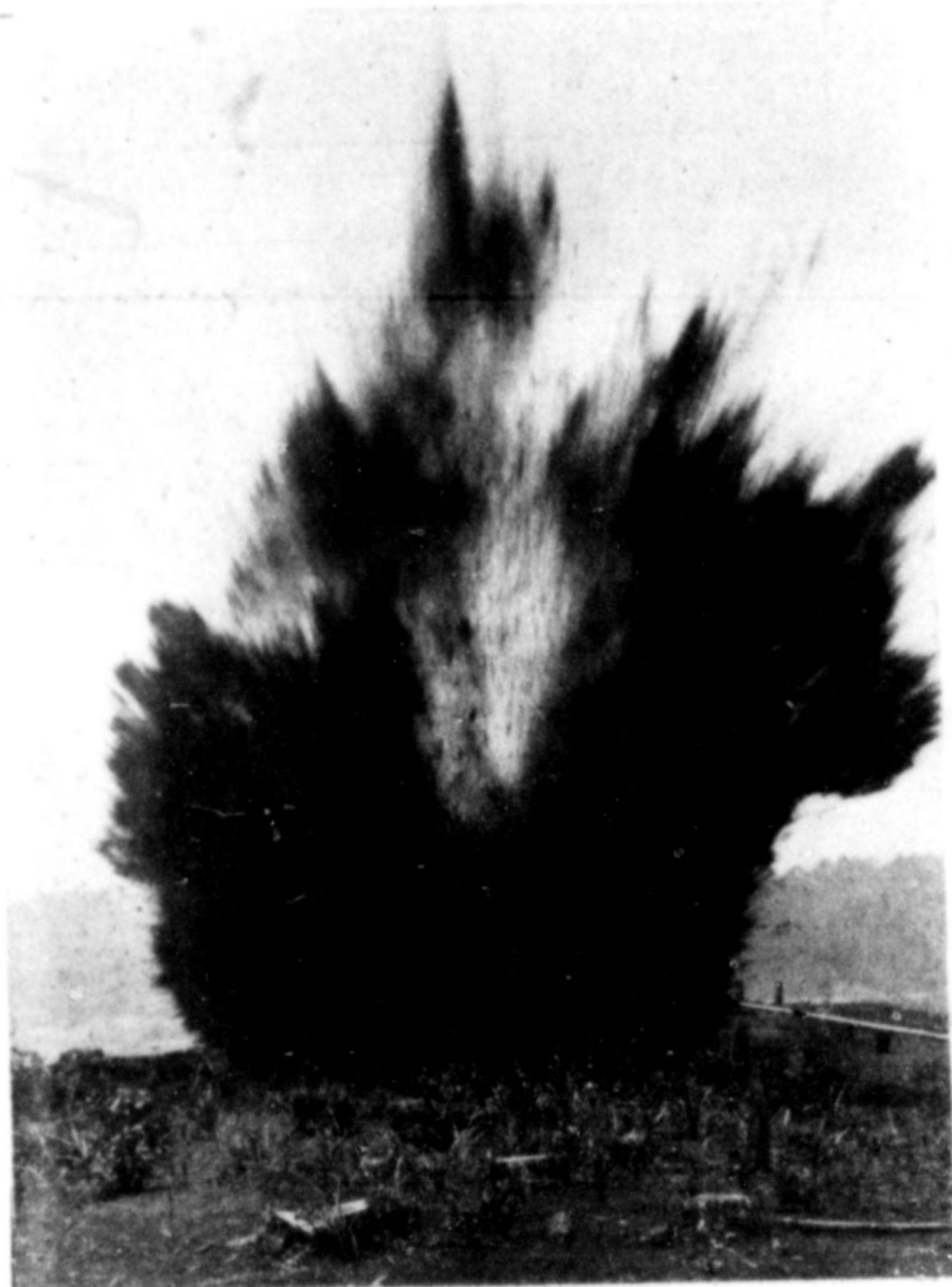
寫眞23 池内整理のための抜根作業 (6年8月)
