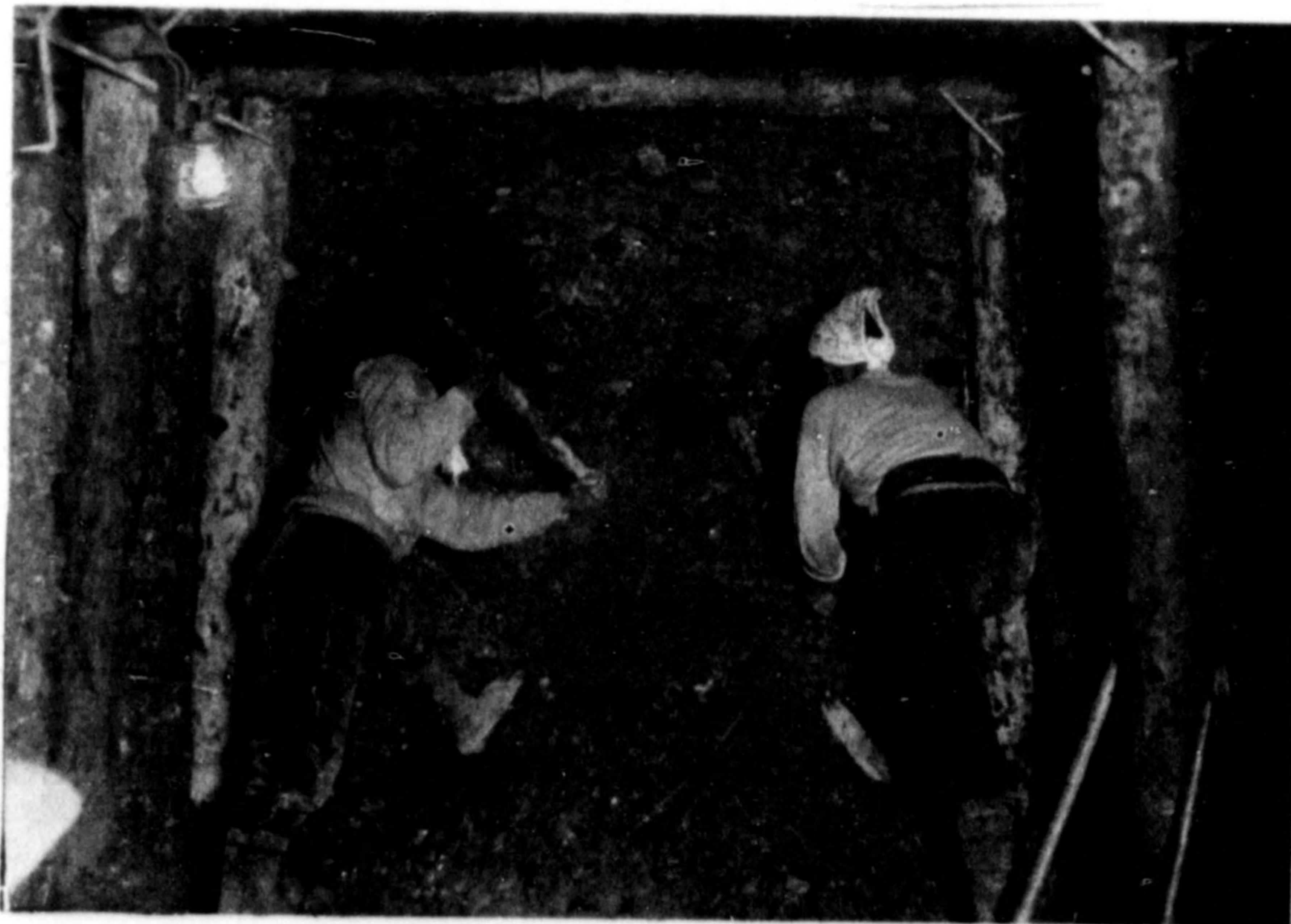
写真12、堰堤混凝土止水壁個所の堤心掘鑿（5年8月）
