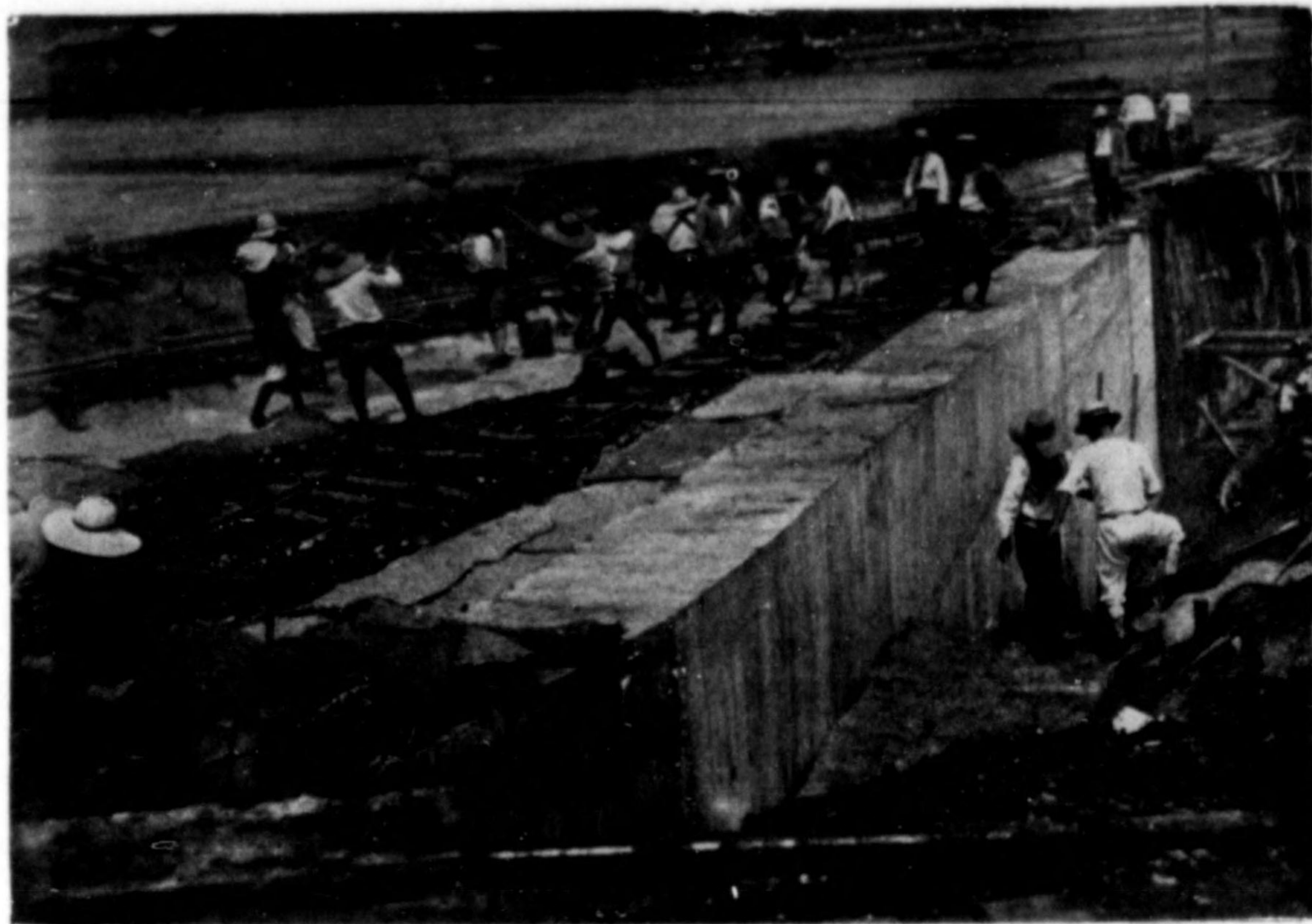
寫眞13. 堰堤の混凝土止水壁 (5年8月)
