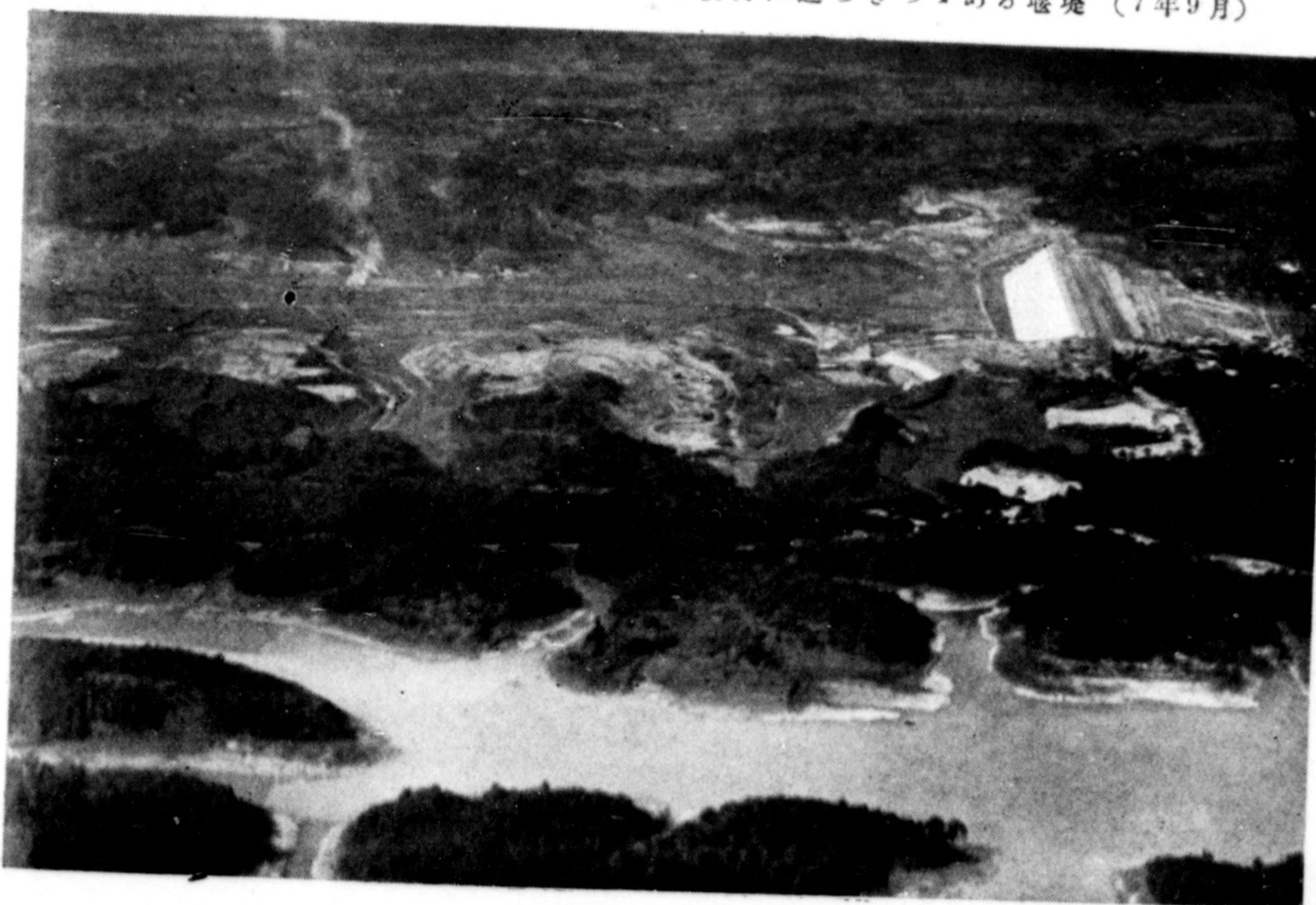
寫眞22、村山貯水池上空より見たる竣工に近づきつゝある堰堤 (7年9月)
