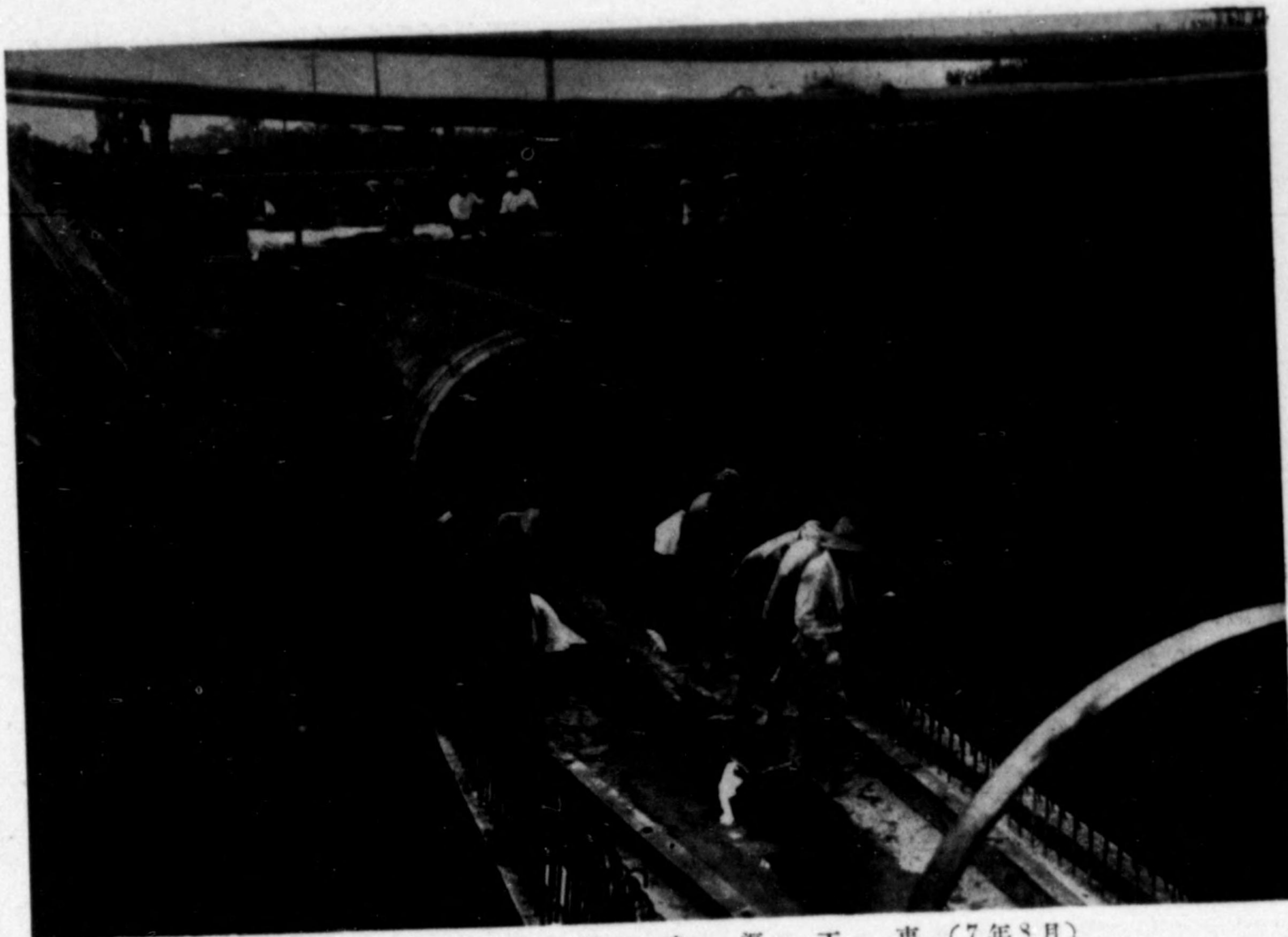
写真43、引出水路暗渠工事（7年8月）
