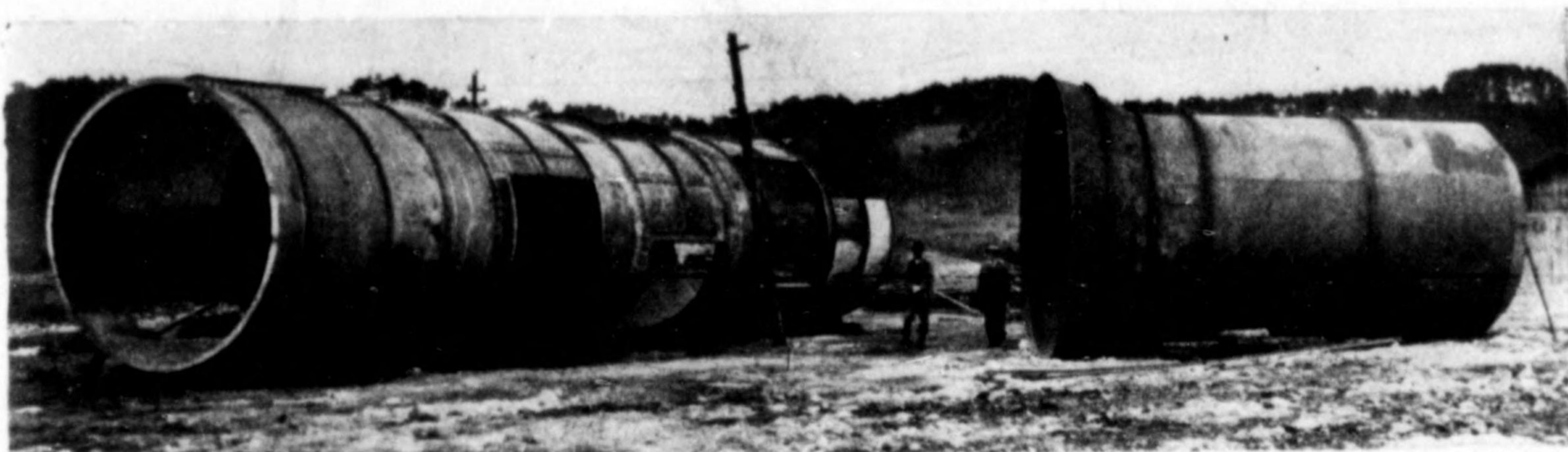
寫眞39、取水塔内部ライニング用鐵管(6年12月)
